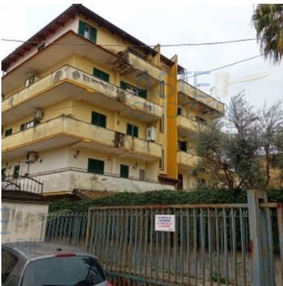
Figura 8 facciata nord/est del fabbricato alla via Umberto Terracini n.23/A in Marano di Napoli
