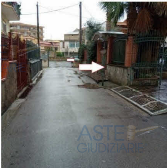
Figura 5 accesso al fabbricato da via Umberto Terracini n.23/A – Marano di Napoli
