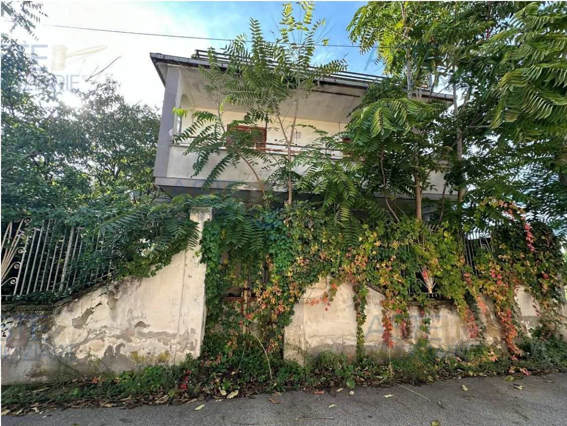
Foto 02 – Lo stabile dalla via G. Savonarola – lato Nord
