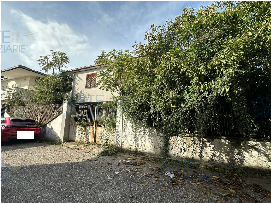
Foto 04 – Lo stabile dalla traversa di via G. Savonarola – lato Est
