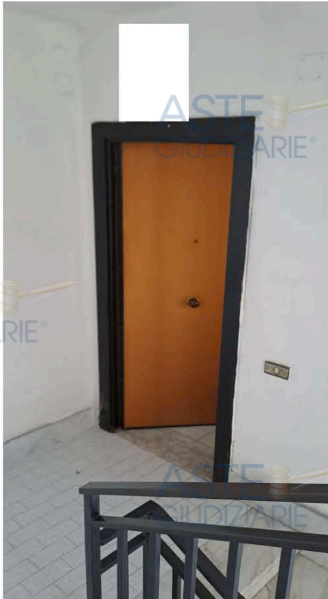
INGRESSO APPARTAMENTO (Primo piano) DAL VANO SCALA
