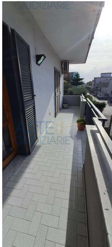
BALCONE (lato OVEST)
