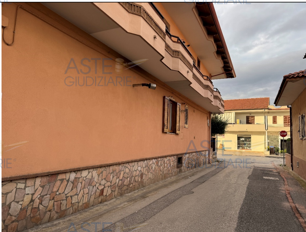
Esterno fabbricato fronte Est
