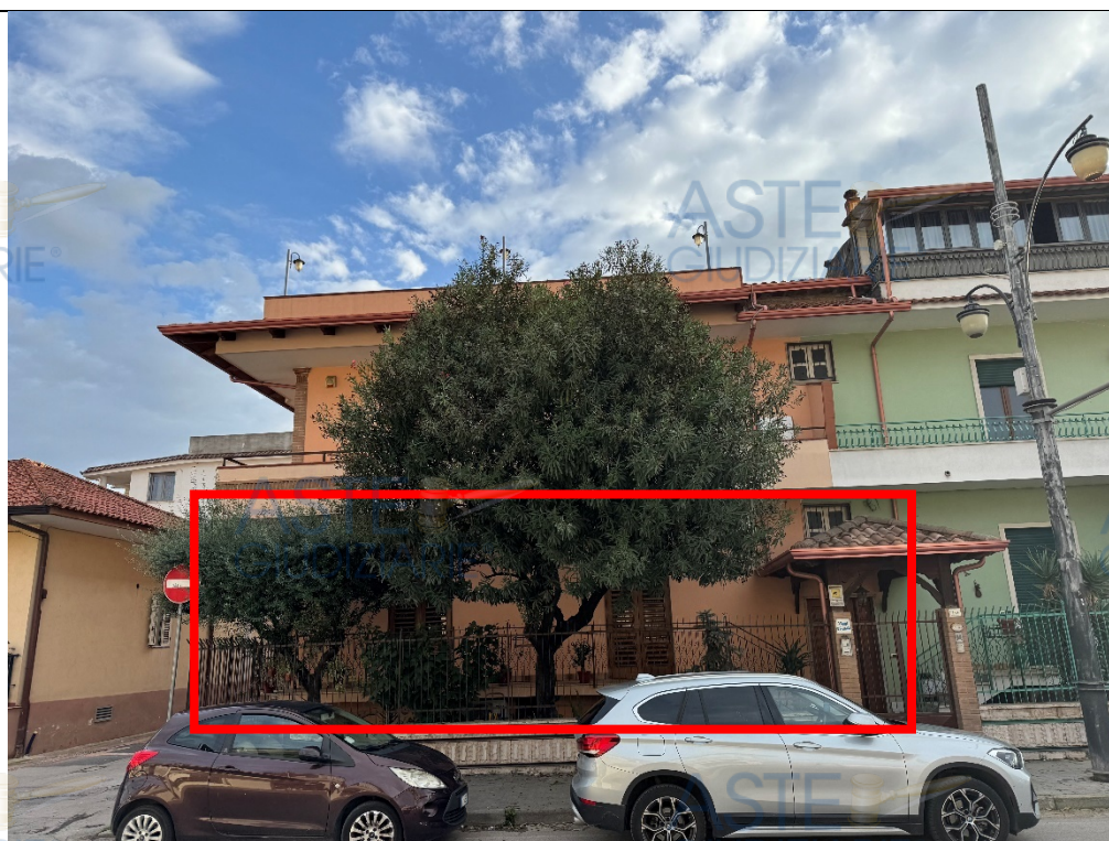
Esterno fabbricato fronte Nord
