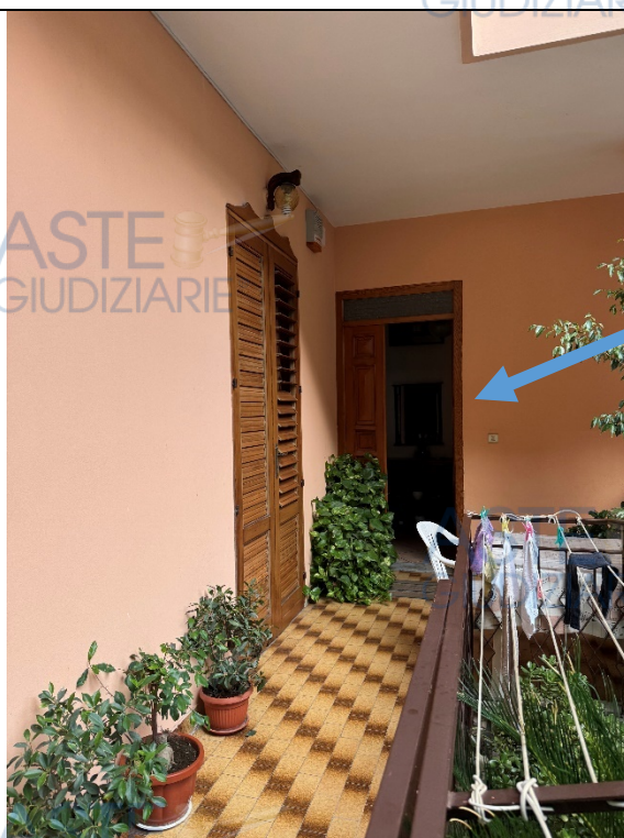
Accesso al sub.2 da area di corte
