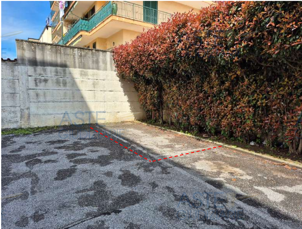
Vista esterna posto-auto scoperto
