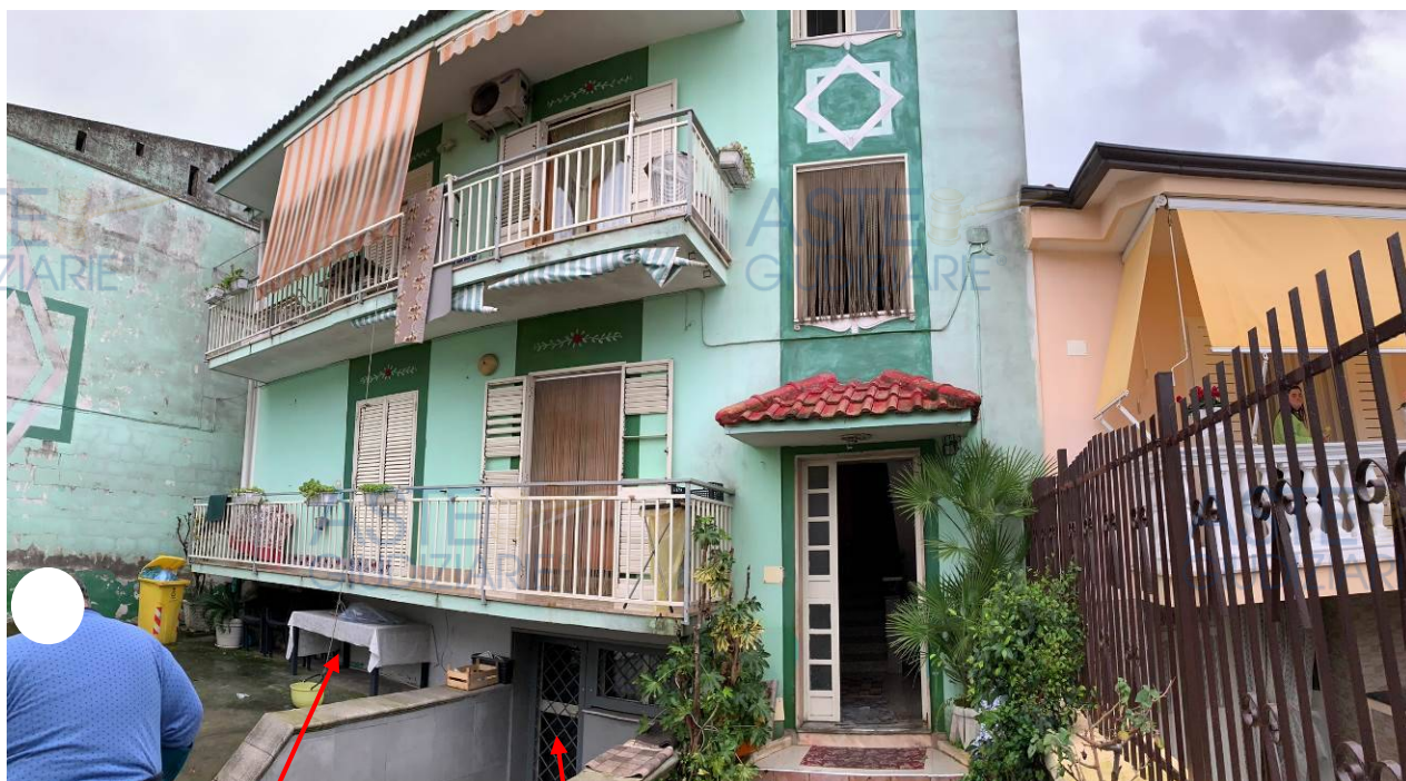
Finestra e porta finestra lato NordOvest
