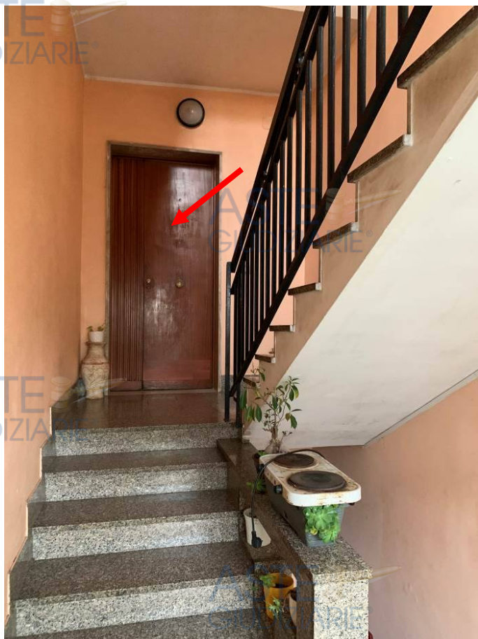
Foto 03 – Le scale comuni ed accesso al sub 1
