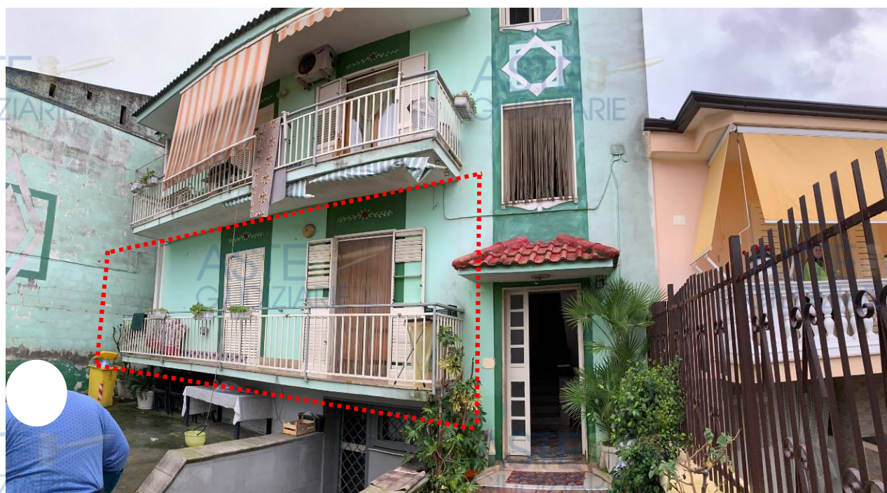
Foto 02 – Il sub 1 dal cortile prospiciente la via Longo (lato NordOvest) e Balcone b1
