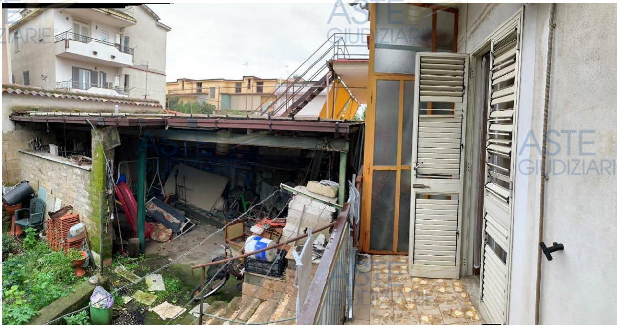
Foto 12 – Balcone B2 e cortile comune lato SudEst
