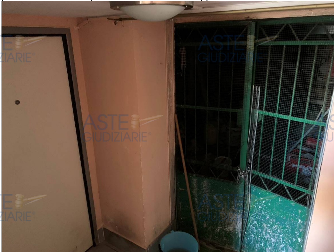
Foto 15 – Accesso ai locali del seminterrato
