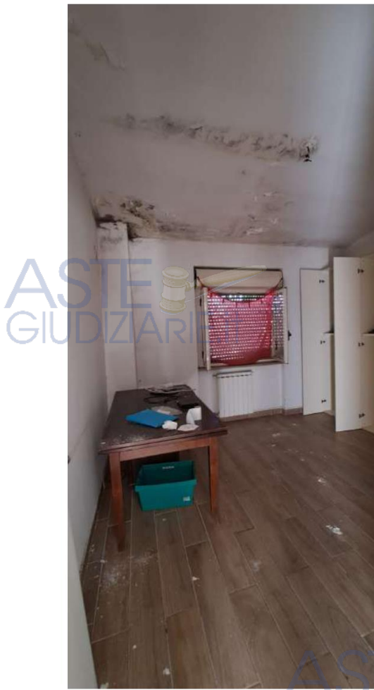
Segni delle infiltrazioni
