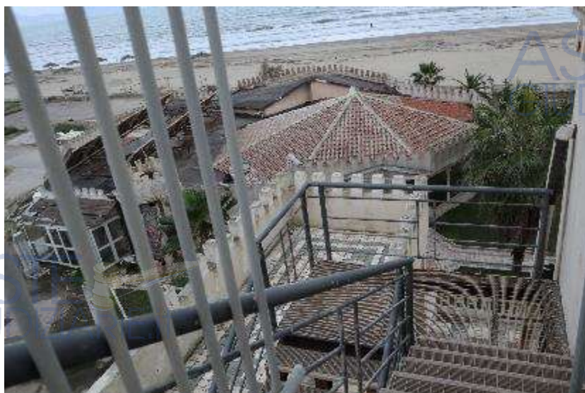
VISTA ESTERNA DELLA SCALA DI SICUREZZA (ALBERGO)
