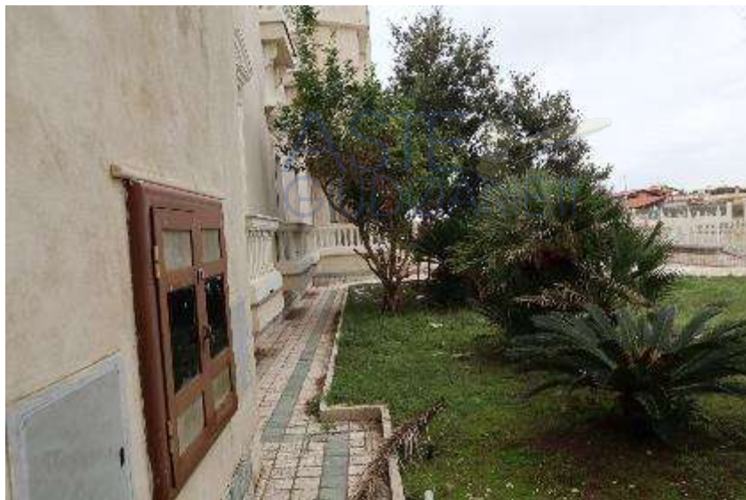
VISTA DELL'AREA ESTERNA
