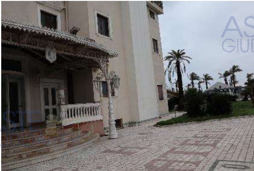
VISTA DELL'AREA ESTERNA
