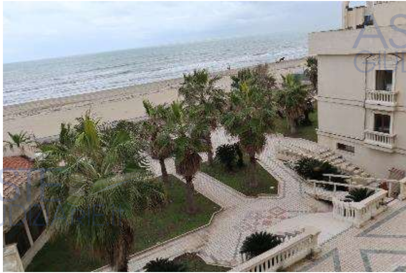
VISTA DELL'AREA ESTERNA
