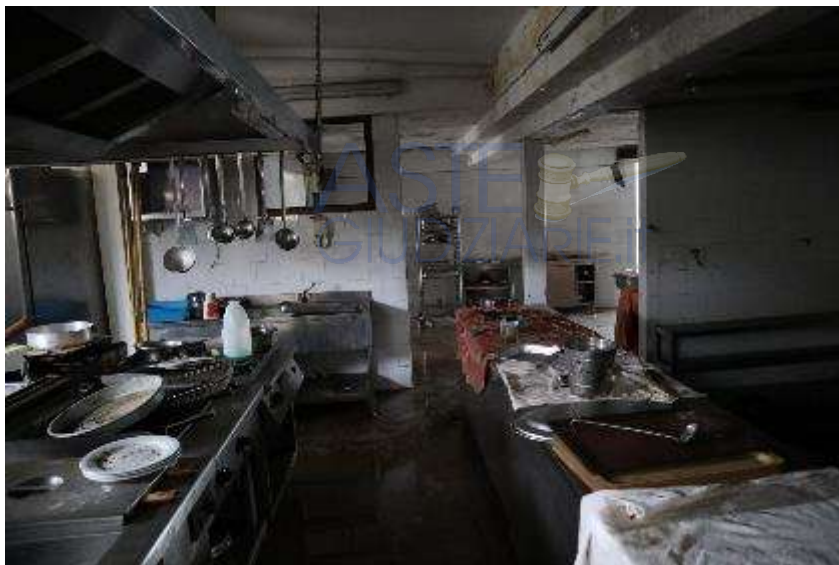
VISTA INTERNA DELLA SALA (RISTORANTE)
