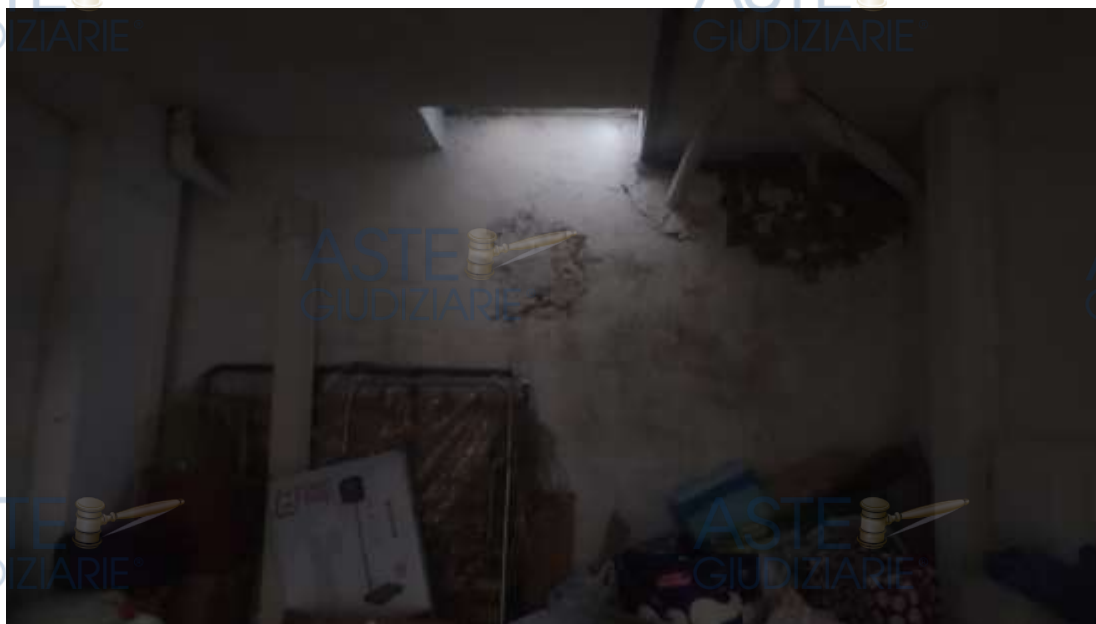
ALTRA VISTA INTERNA
