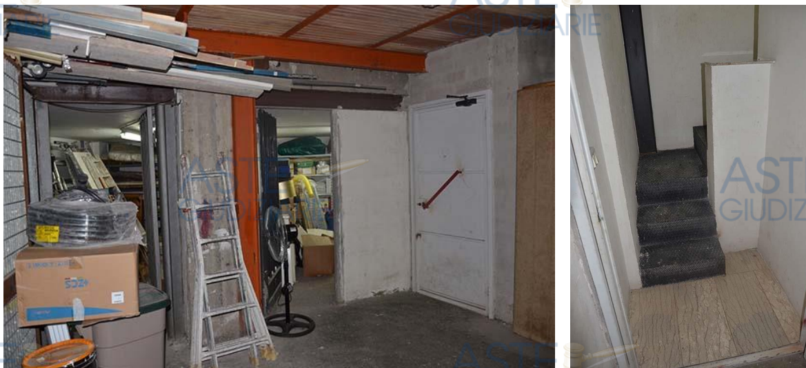
ingresso al corpo scala
