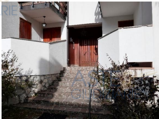
INGRESSO AL PIANO PRIMO
