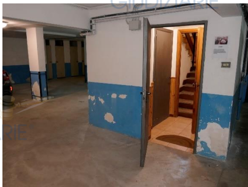
SCALA DI ACCESSO
