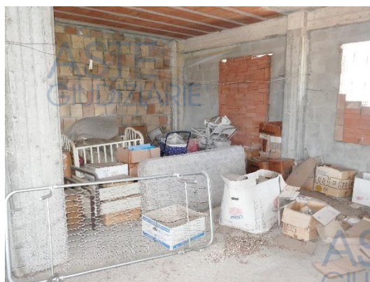
PIANO SECONDO - IN COSTRUZIONE
