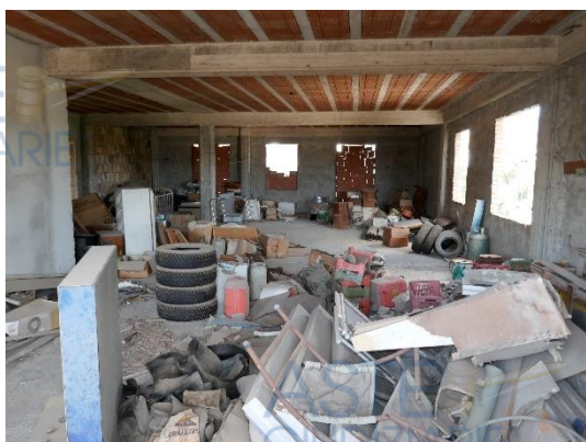
PIANO SECONDO - IN COSTRUZIONE
