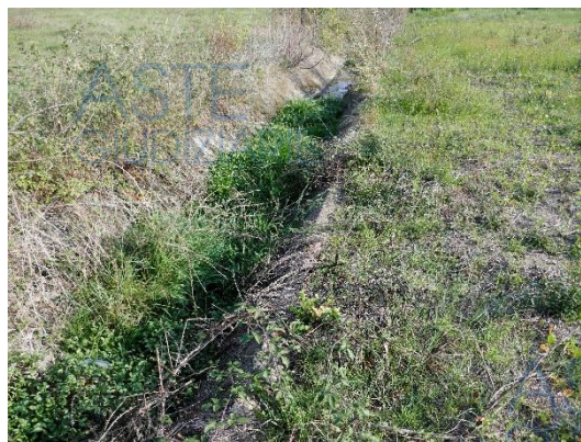
FOSSO DI SCOLO CONFINE EST
