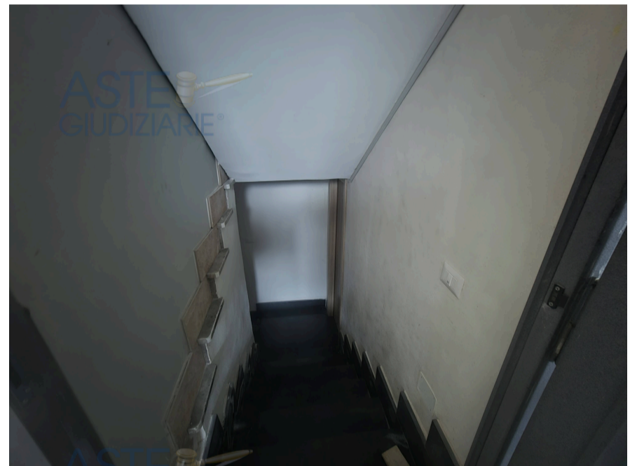
scala di accesso
