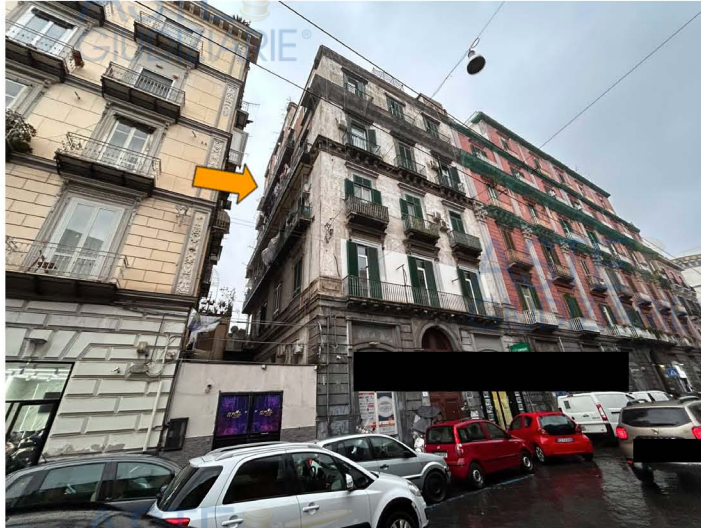
Veduta esterna del fabbricato da Via Cesare Rosaroll
