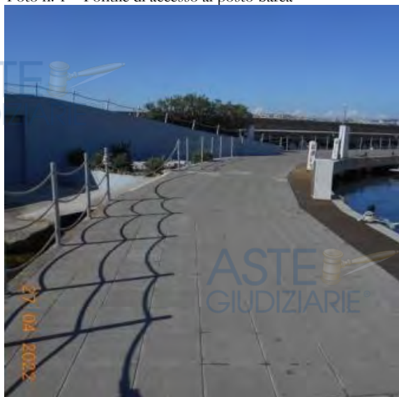
Foto n. 1 – Pontile di accesso al posto barca
