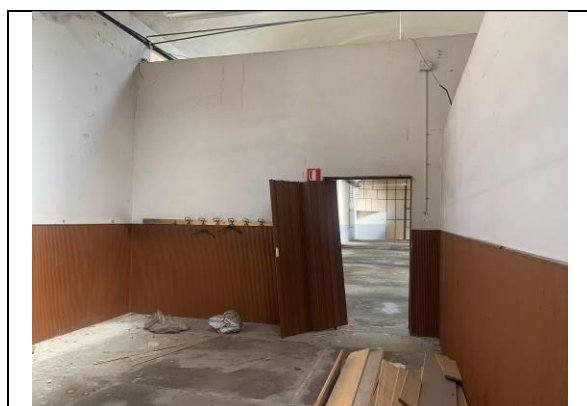
Immagine n. 28 - Deposito
