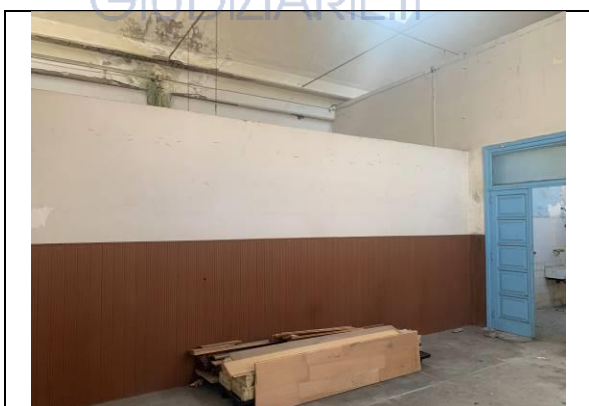
Immagine n. 27 - Deposito
