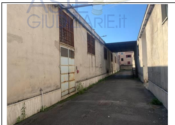
Immagine n. 3 - Esterno Capannone
