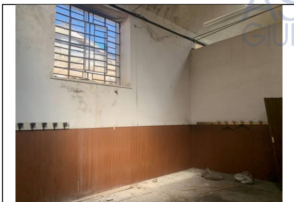
Immagine n. 29 - Deposito
