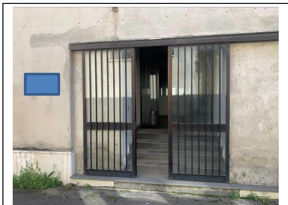
Immagine n. 1 - Ingresso uffici
