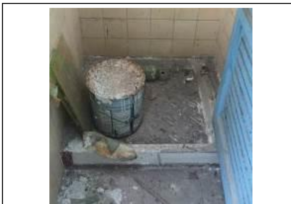
Immagine n. 22 - Locali bagno
