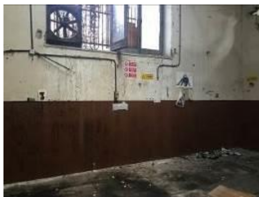
Immagine n. 49 - Dettaglio parete perimetrale
