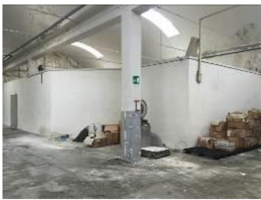
Immagine n. 41 - Vista d'insieme locale uffici
