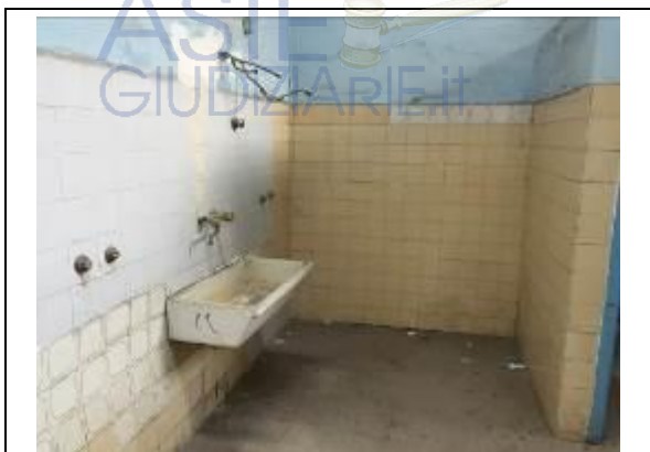
Immagine n. 24 - Locali bagno
