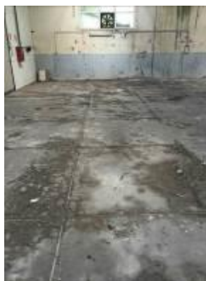
Immagine n. 9 - Pavimentazione
