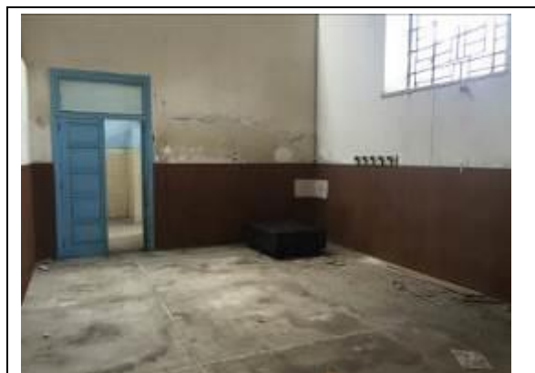
Immagine n. 25 - Locale antibagno
