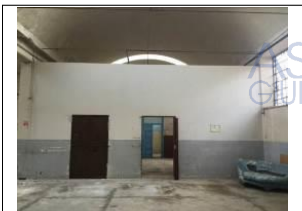
Immagine n. 26 - Vista d'insieme locali bagno
