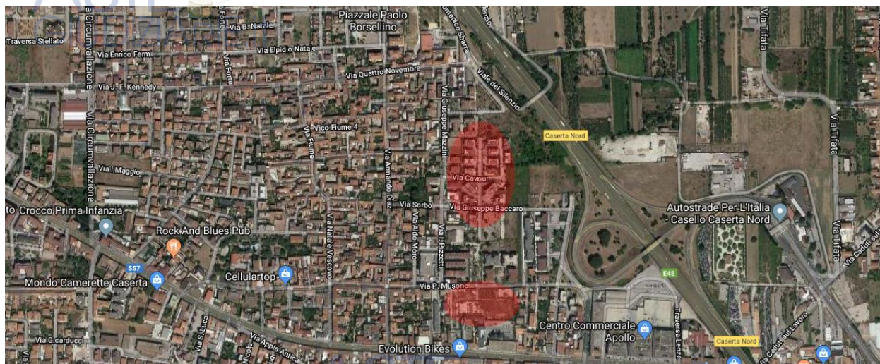
FOTO AEREA CON LA LOCALIZZAZIONE DEGLI IMMOBILI OGGETTO DI STIMA
