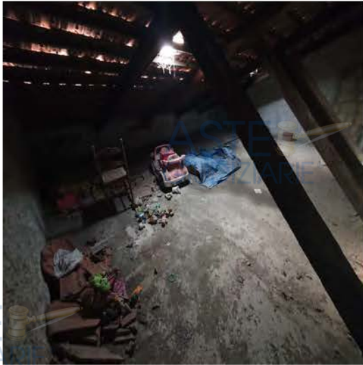
Foto n. 13 – Beni all'interno del sottotetto
