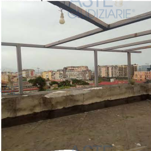
Foto n. 3 – Copertura del sottotetto rimossa
