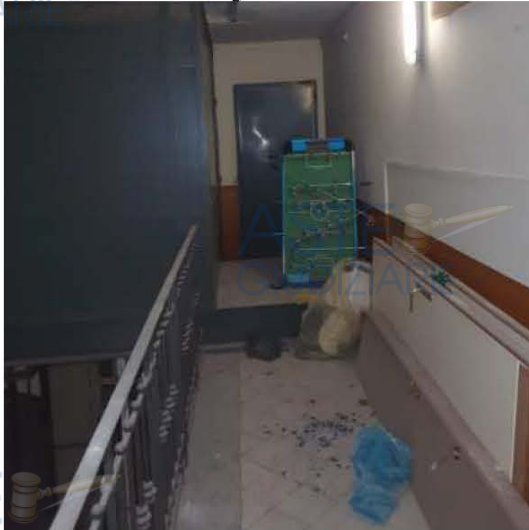
Foto n. 25 – Materiale all'ingresso del sub. 138
