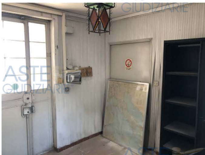
Interno del manufatto adibito ad uffici (foto 11)
