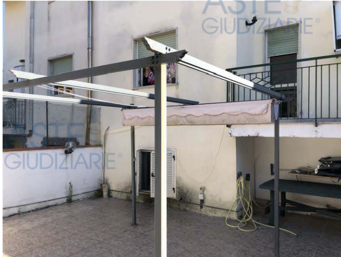
Esterni lato retrostante (foto 31)
