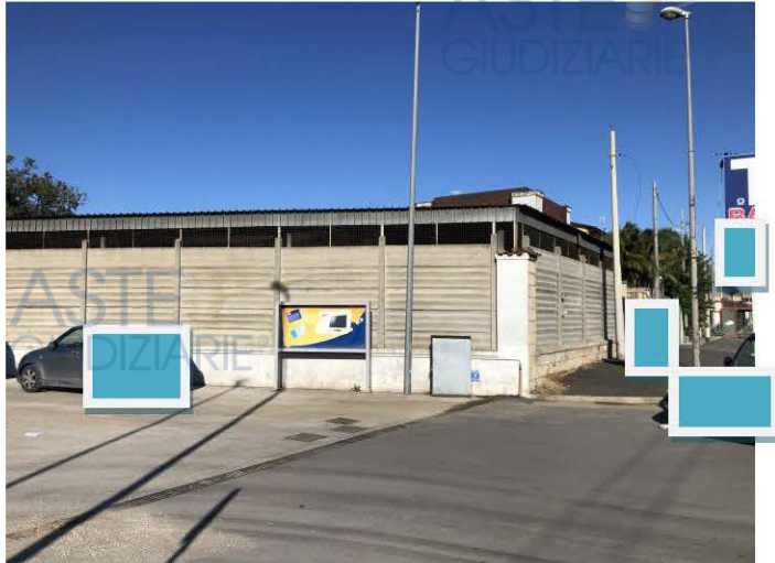
Esterno lotto lato distributore di carburante (foto 22)
