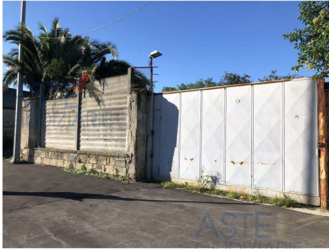
Cancello d'ingresso principale carrabile (foto 1)
