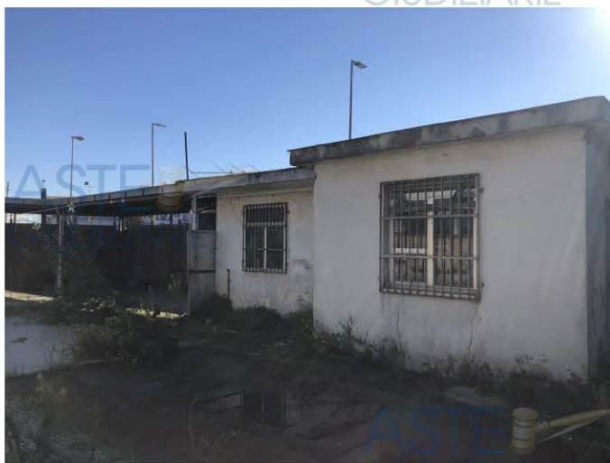
Esterno manufatto adibito ad uffici (foto 9)
