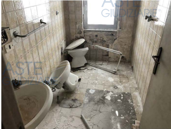
Interno del manufatto adibito ad uffici (foto 13)
