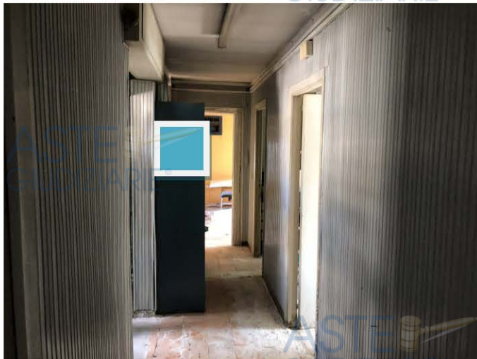
Interno del manufatto adibito ad uffici (foto 15)
