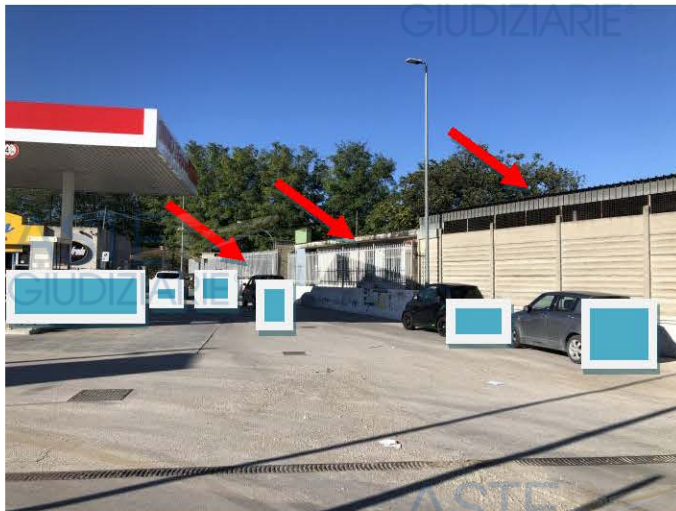
Esterno lotto lato distributore di carburante (foto 23)
