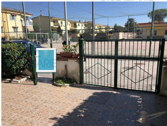
Esterni lato ingresso (foto 30)
