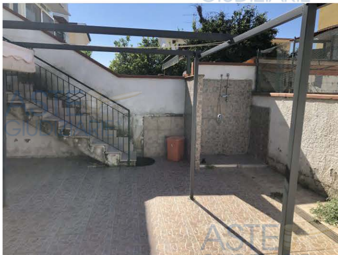
Esterni lato retrostante (foto 33)
