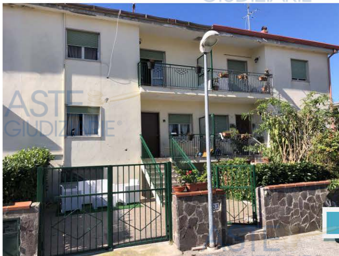
Esterni lato ingresso (foto 27)
