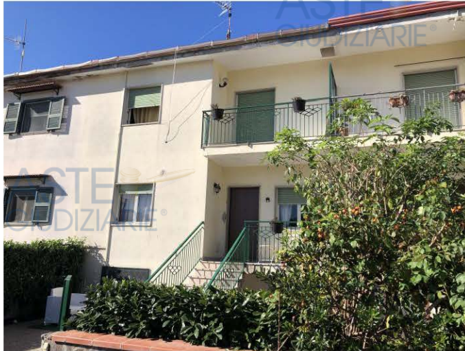
Esterni lato ingresso (foto 28)
