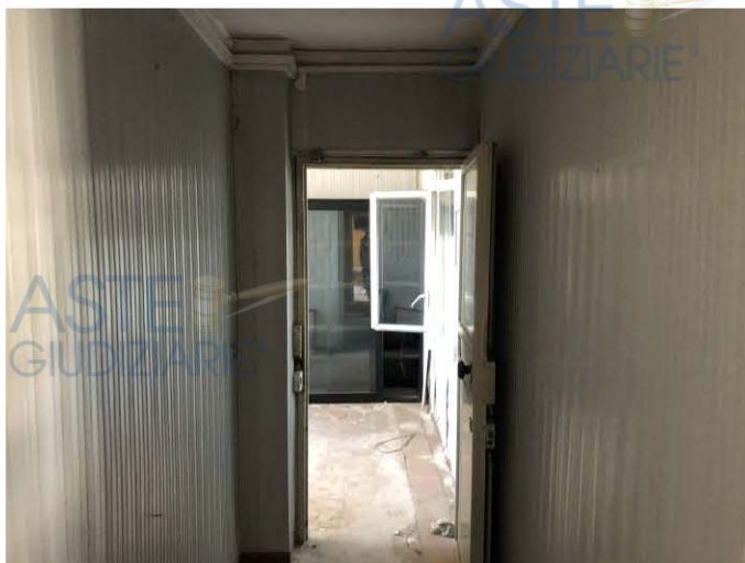
Interno del manufatto adibito ad uffici (foto 10)
