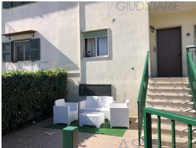
Esterni lato ingresso (foto 29)
