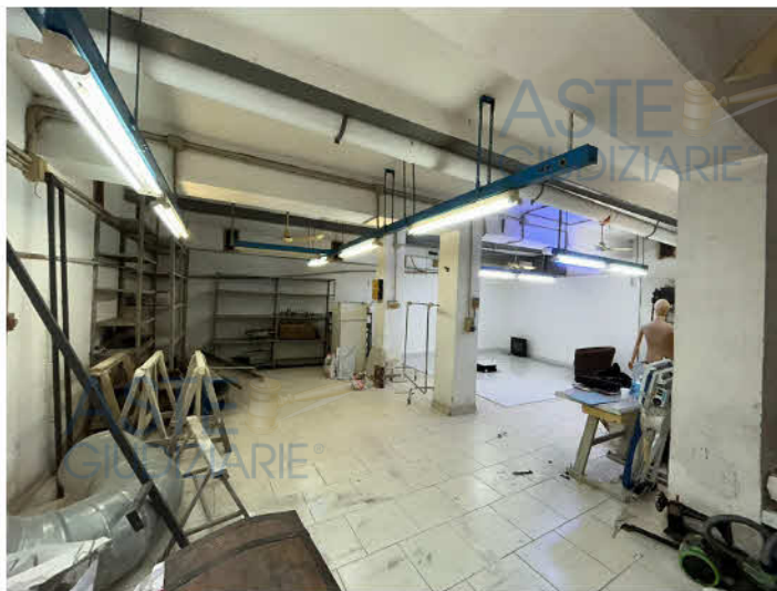
Particolare dell'ambiente principale
