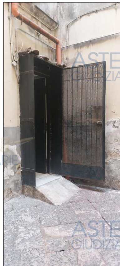
Ingresso al locale deposito
