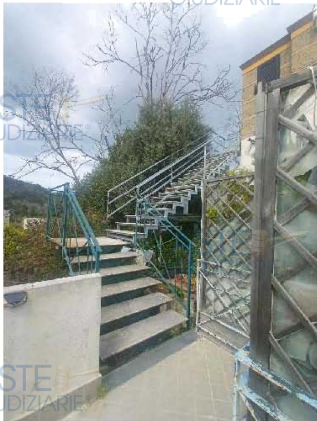
Foto 1 – Scala di accesso posta sul versante ovest del fabbricato
