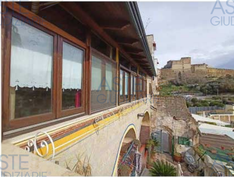
Foto 3 – Corridoio (esterno) realizzato in ampliamento sull'originario ballatoio
