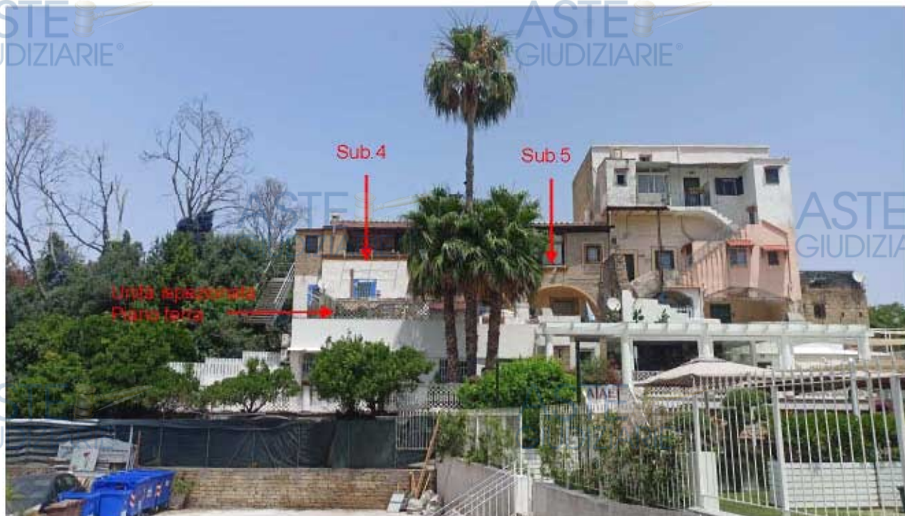
Fig. 11 - Vista esterna del fabbricato (da via Castello) Si individua la posizione degli immobili pignorati sul prospetto sud del fabbricato. Al primo piano vi è l'appartamento formato dalle due distinte unità immobiliari (sub. 4 e sub. 5 della p.la 55, foglio 12, NCEU del Comune di Bacoli) unite di fatto, che costituiscono il LOTTO 1. Al piano terra, in corrispondenza del sub. 4 posto al primo piano, si colloca l'immobile ispezionato, individuato dal debitore esecutato in sede di sopralluogo quale sub. 12 e che costituisce un distinto lotto di vendita (LOTTO 2).
