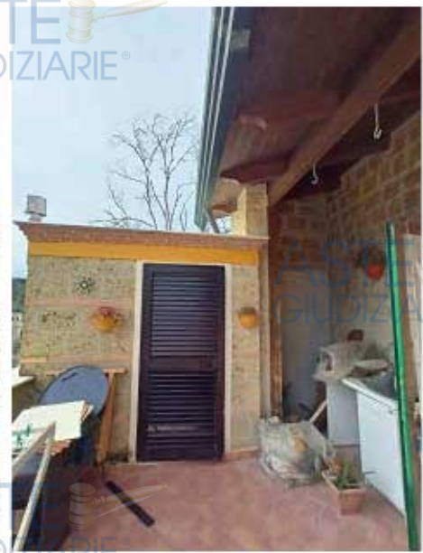
Foto 4 – Vano esterno posto sul terrazzo
