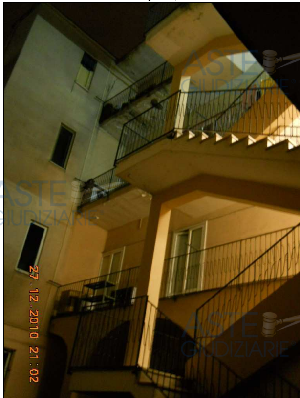
Ripresa n. 2: immobile de quo distinto con l’interno n.6, con affaccio sul cortile comune (VILLARICCA - NA).
