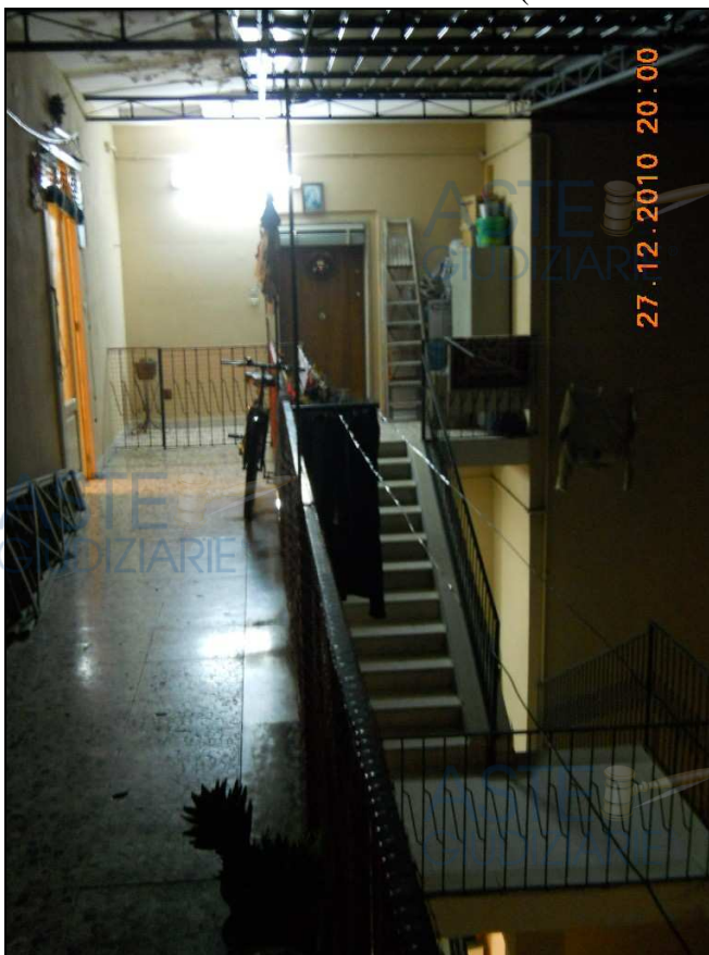
Ripresa n. 4: scala interna al cortile comune ed ingresso dell'appartamento in questione, distinto con il numero interno 7 (VILLARICCA - NA).
