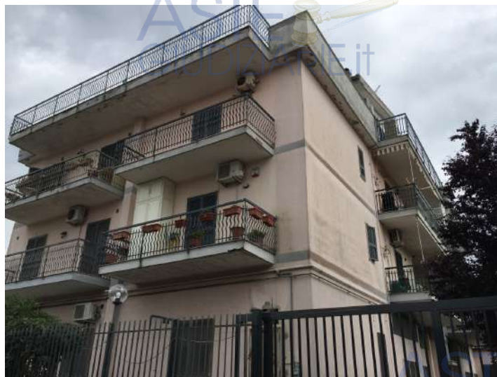
Vista del fabbricato
