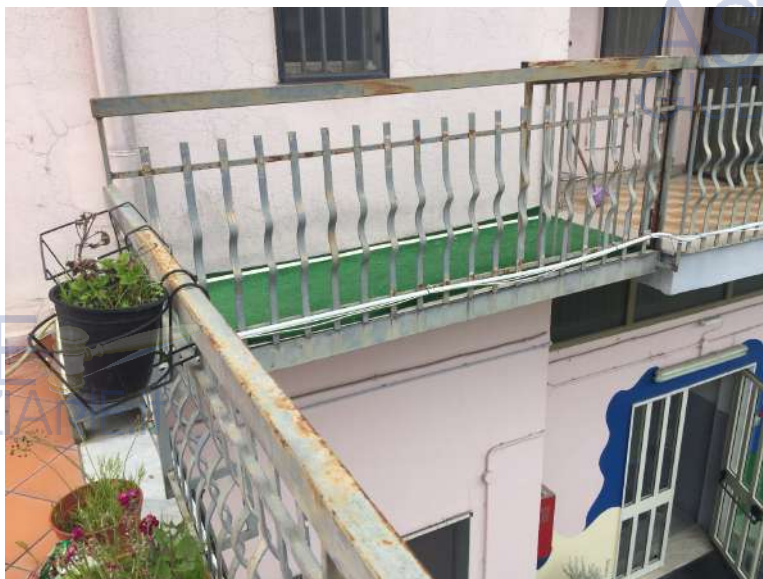
Passetto di collegamento balcone – terrazzo
