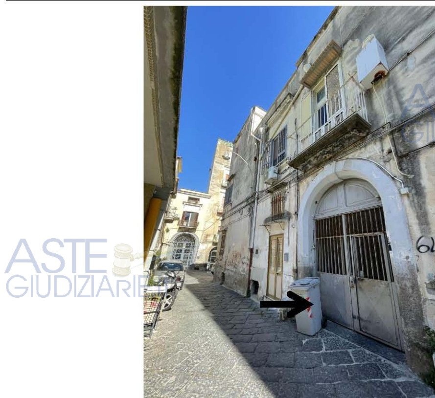
Vico dei Cangi. Si evidenzia il portone di accesso al fabbricato
