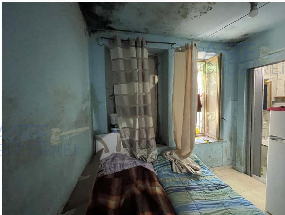
Canera da letto 2. Si evidenziano infiltrazioni e muffe sulle suppoerfici murarie.
