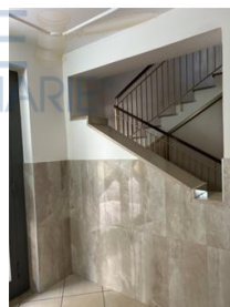
Foto n. 11 - Parco Verde - Palazzo il Tiglio - androne
