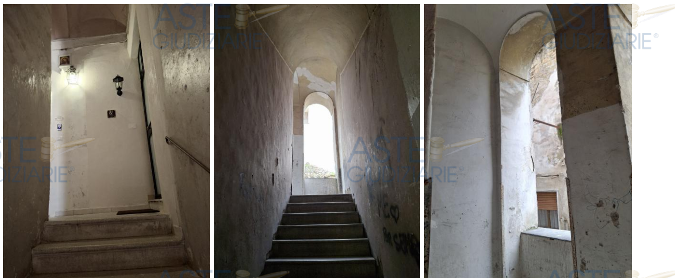
Figg. 21, 22 e 23 - Fabbricato e scala condominiale
