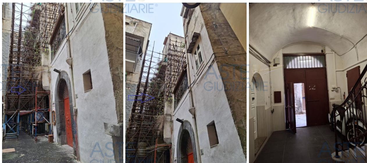
Figg. 10, 11 e 12 - Fabbricato (sinistra, centro e destra) visto da vico Tarallari (sinistra e centro) e androne coperto comune (destra)
