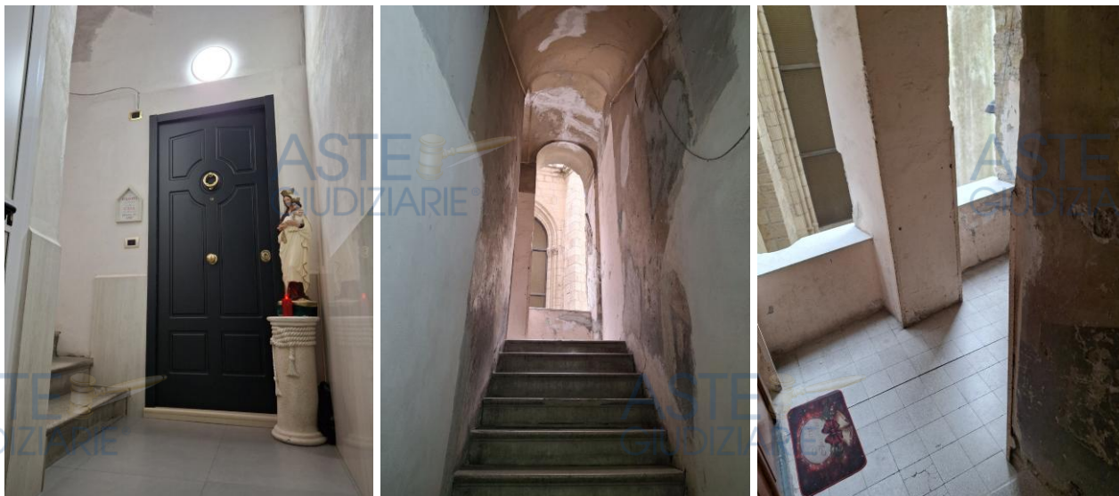
Figg. 18, 19 e 20 - Fabbricato e scala condominiale
