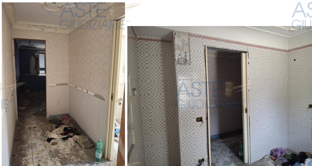
Figg. 74 e 75 - Disimpegno (sinistra e centro) e bagno (destra)
