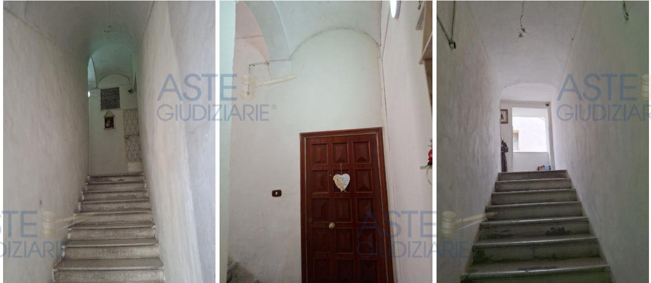
Figg. 24, 25 e 26 - Fabbricato e scala condominiale
