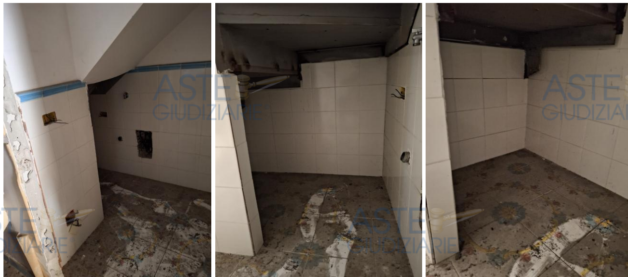
Figg. 50, 51 e 52 - Vano con lavabo e lavatoio
