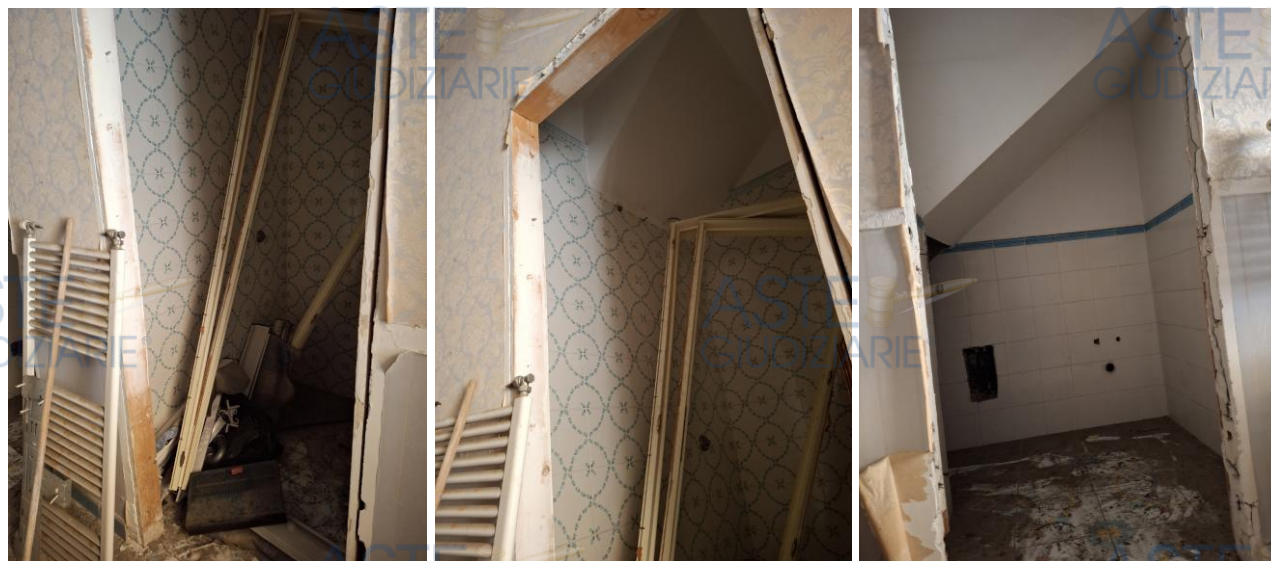
Figg. 47, 48 e 49 - Servizio igienico (sinistra e centro) e vano con lavabo e lavatoio (destra)
