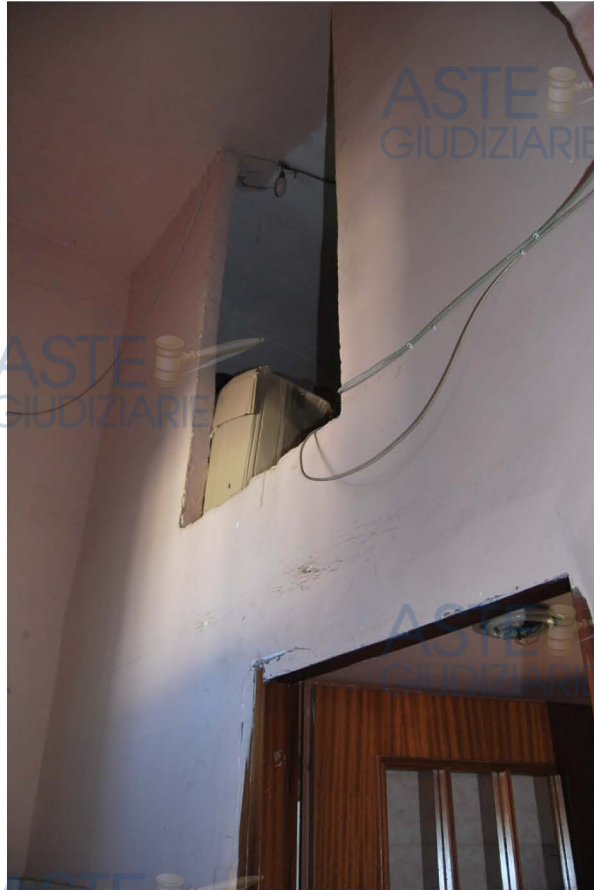
FOTO 13 PARTICOLARE SOPPALCO BAGNO U. IMMOBILIARE PORZIONE 2
