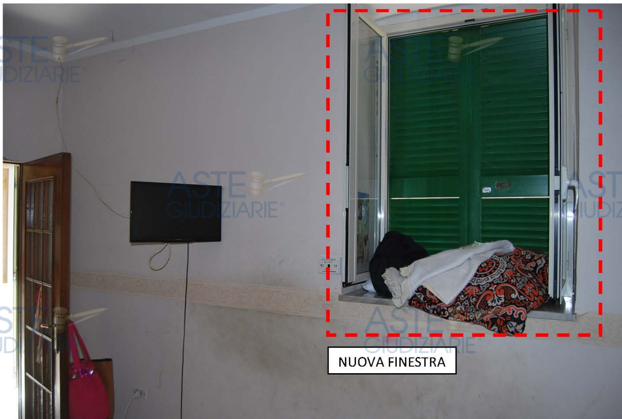
FOTO 15 PARTICOLARE NUOVA FINESTRA LETTO U. IMMOBILIARE PORZIONE 2
