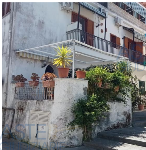
FOTO STATO ATTUALE
