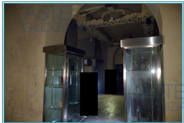
Figura 35 Sala3 - Piano Interrato
