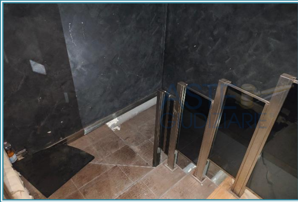
Figura 26 Vista su scala per accedere al piano interrato
