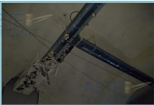
Figura 36 Particolare soffitto a volta - Piano Interrato
