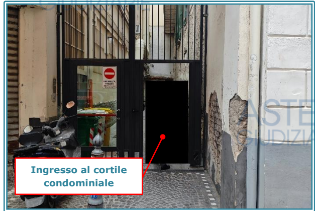
Figura 9 Ingresso al condominio
