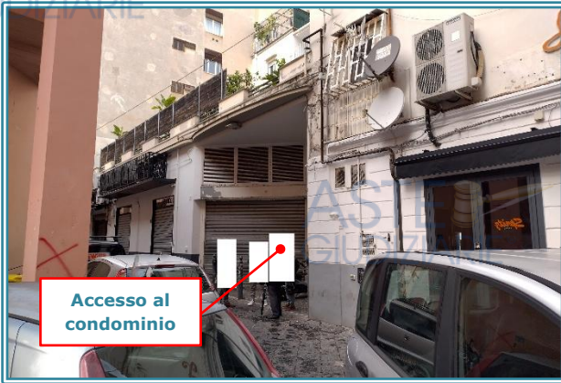
Figura 8 Vista fabbricato da Vico dei Sospiri
