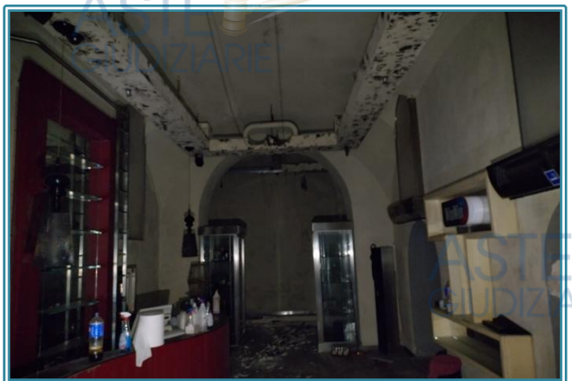
Figura 31 Sala2 - Piano Interrato
