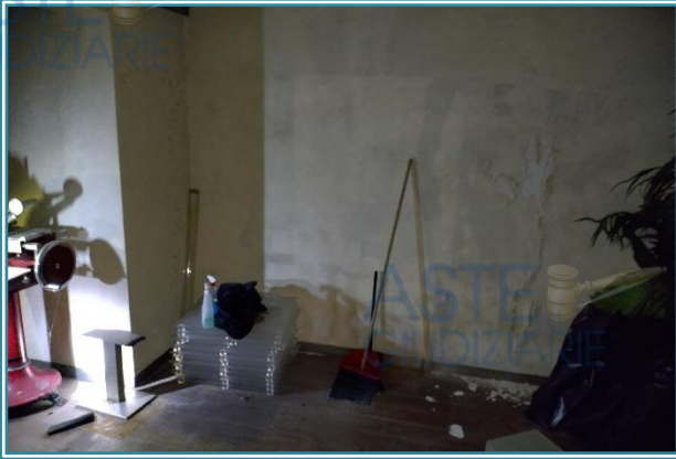
Figura 38 Sala4 – Piano Interrato
