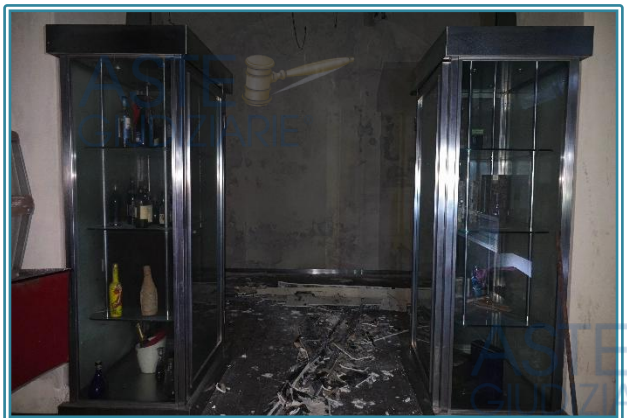
Figura 37 Sala3 - Piano Interrato
