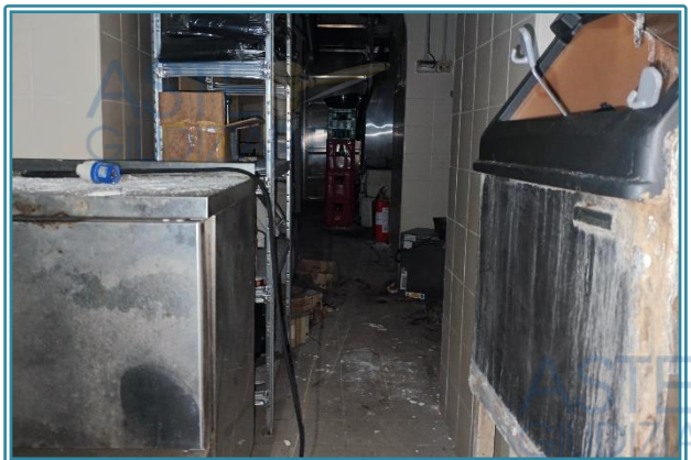
Figura 43 Locale Lavorazione – Piano Interrato
