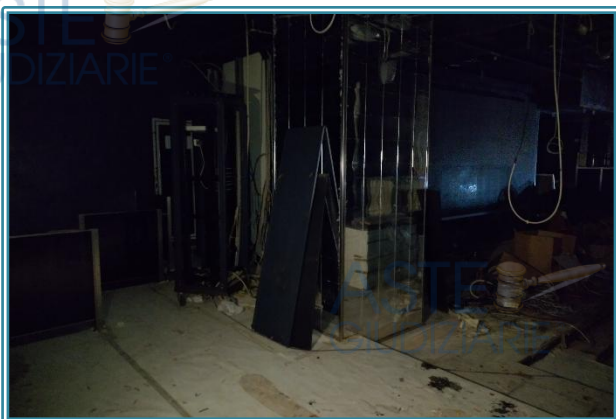
Figura 18 Sala1 - Piano Terra
