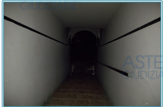
Figura 29 Scala di accesso al piano interrato
