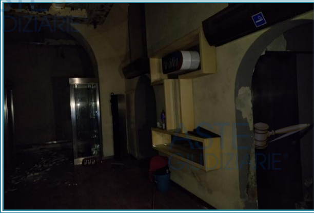
Figura 32 Sala2 - Piano Interrato
