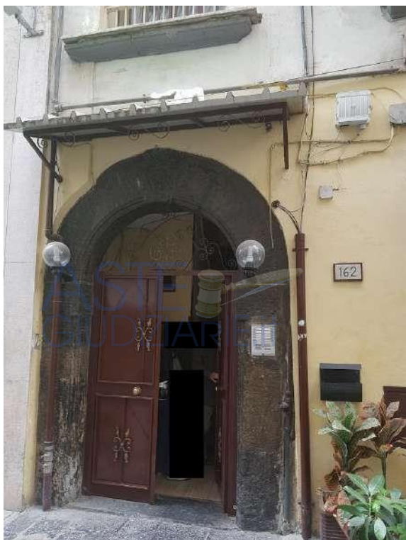
Vista portone di accesso dell'immobile
