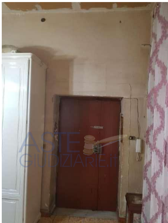
Vista Vano di ingresso cespite pignorato
