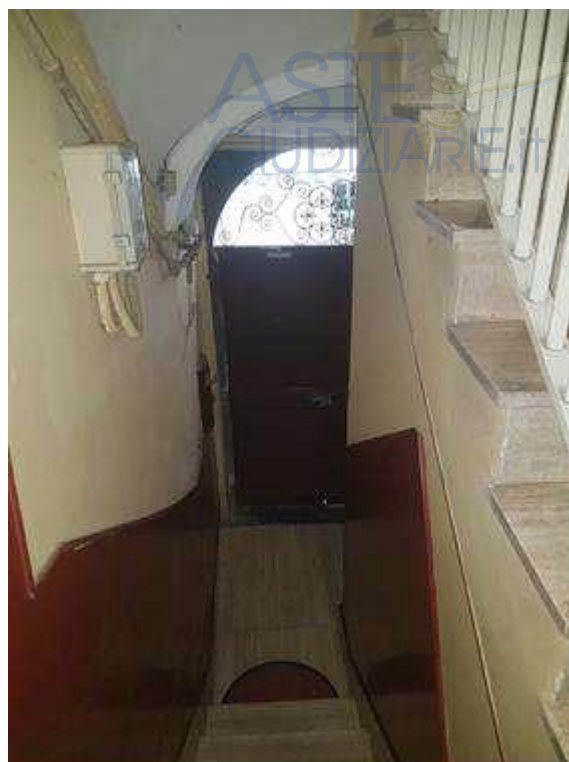
Vista accesso all'immobile
