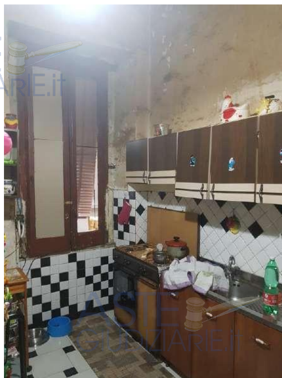
Vista locale cucina
