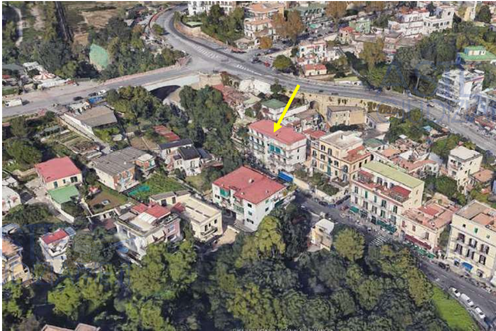
Fotografia 3 – Inquadramento territoriale lato Sud.
