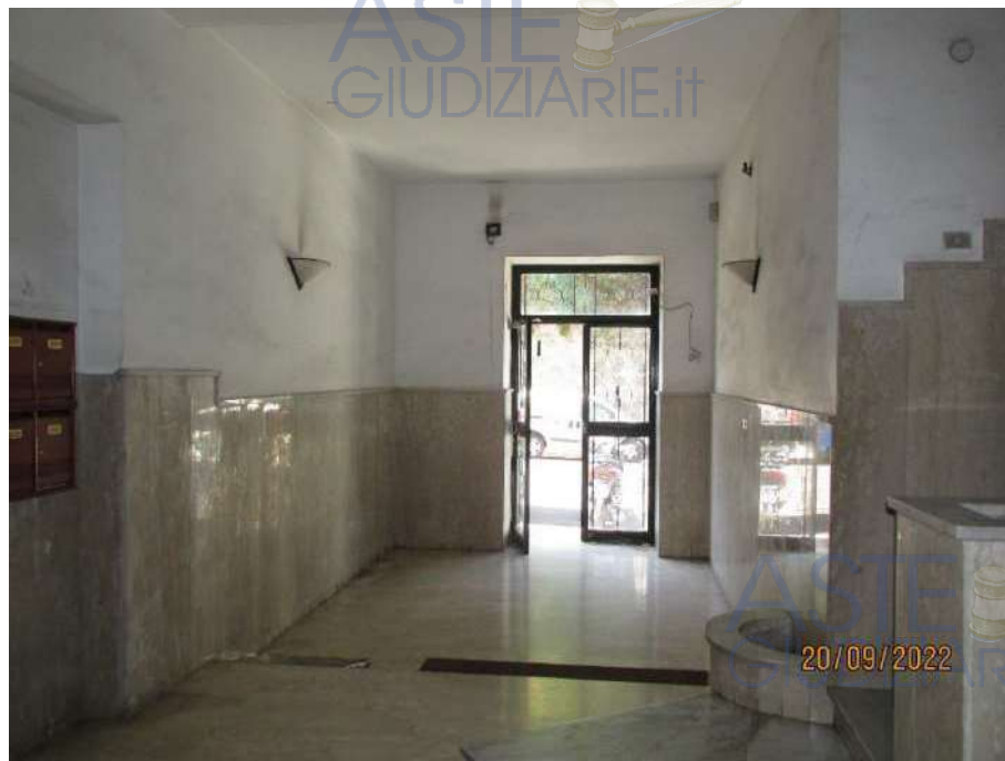
Fotografia 11 – L'androne è interamente pavimentato con lastre in marmo beige; presenta le pareti rivestite con intonaci ordinari a finitura liscia e tinteggiate con pittura lavabile nella parte superiore, mentre la parte inferiore, per circa 1,50 ml dal piano di calpestio, è rivestita con lastre in marmo beige.
