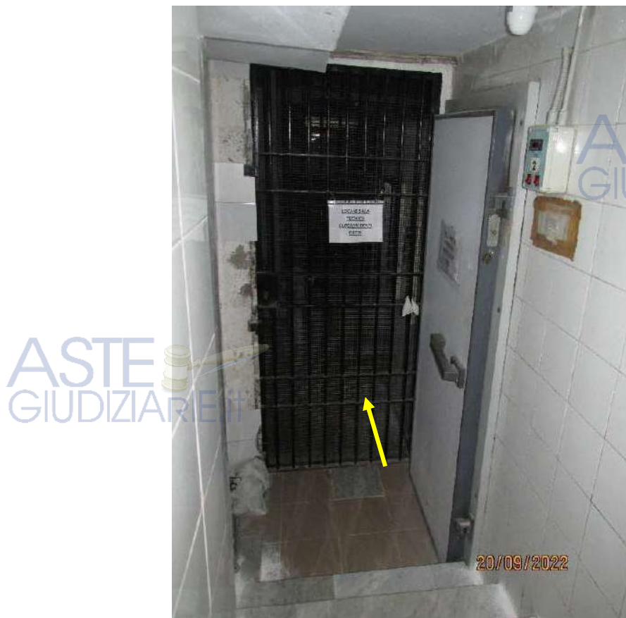
Fotografia 23 – Locale 2/a Sub 102: vi si accede tramite un serramento in ferro posto di fronte al piccolo ballatoio del piano seminterrato alla destra di chi scende le scale.
