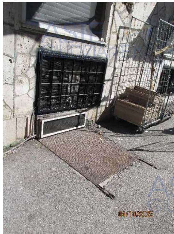
Fotografia 32 – Locale 2/a Sub 102: Il punto di scarico merci risulta protetto esternamente sul marciapiede da una piastra in ferro removibile, mentre internamente al locale l'apertura è protetta da una cancellata in ferro.
