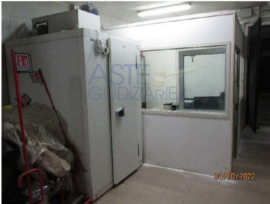
Fotografia 34 – Locale 2/a Sub 102: nel locale è presente una cella frigorifero di modeste dimensioni.
