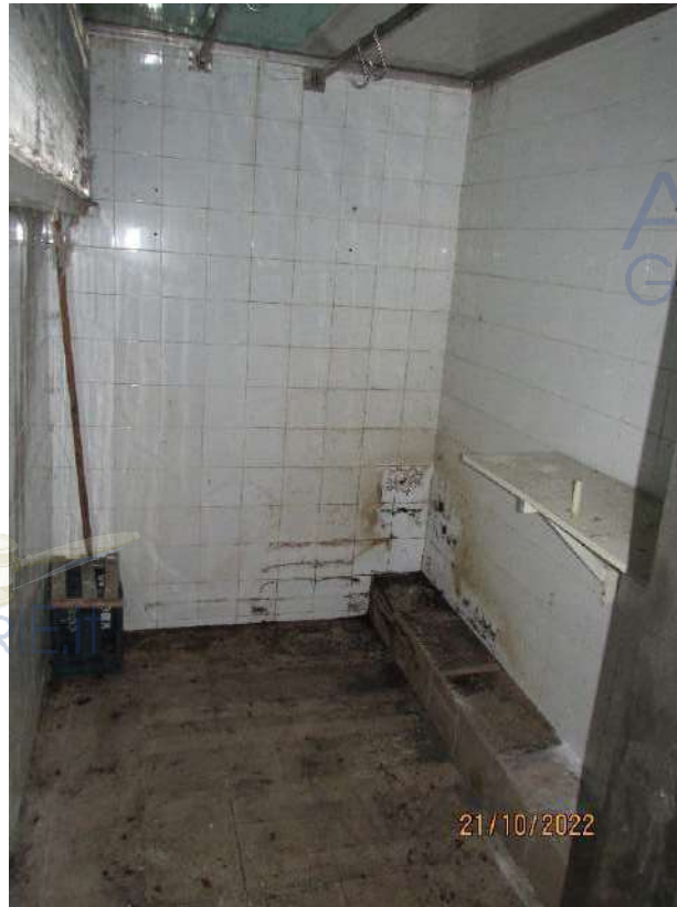
Fotografia 21 – Locale 1 Sub 101: Il locale attualmente è destinato a cella frigorifero, l'una superficie calpestabile utile netta pari a mq. 5,60 e un'altezza di piano di calpestio pari a ml. 2,80. La pavimentazione e le pareti risultano interamente rivestite con piastrelle di ceramica smaltata mentre il soffitto risulta costituito da pannelli coibentati.
