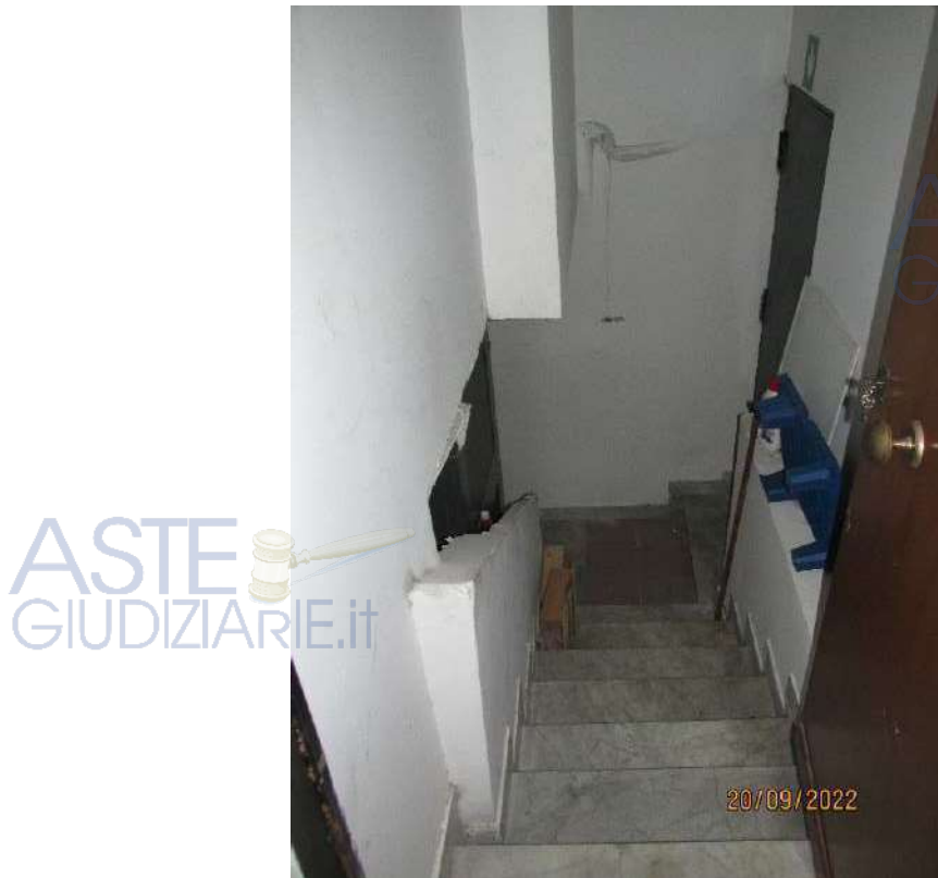
Fotografia 16 – I rampanti di scala che conduce al piano interrato, presentano le pedate dei gradini rivestite con lastre in marmo bianco con venature grigio, intervallate da ballatoi pavimentato con piastrelle in ceramica smaltata.
