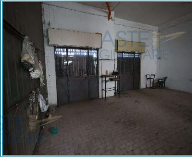
Figura 31 Vista box1 LOTTO 4 fuso con LOTTO 3
