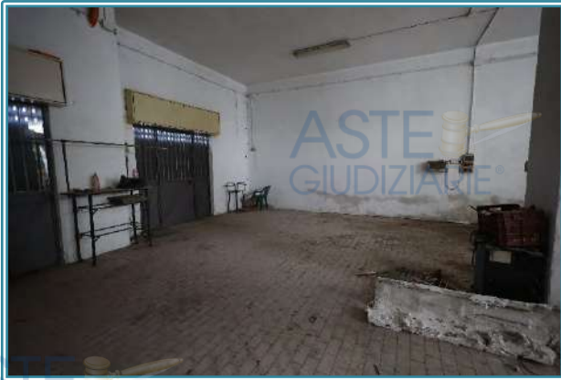
Figura 26 Vista Box LOTTO 3 fuso con LOTTO 4
