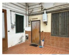
Foto n. 11 - Ballatoio - ingresso all'immobile
