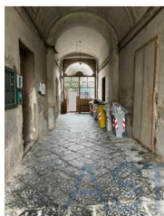
Foto n. 3 - Androne del fabbricato
