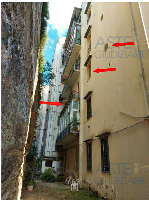
prospetto fabbricato prospiciente intercapedine parete tufacea -
