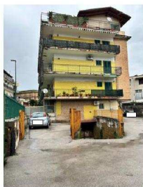
Foto n. 2 - Fabbricato in cui è ubicato l'immobile pignorato
