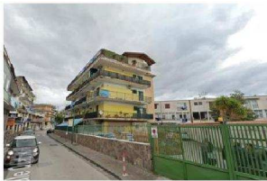
Foto n. 1 - Fabbricato in cui è ubicato l'immobile pignorato
