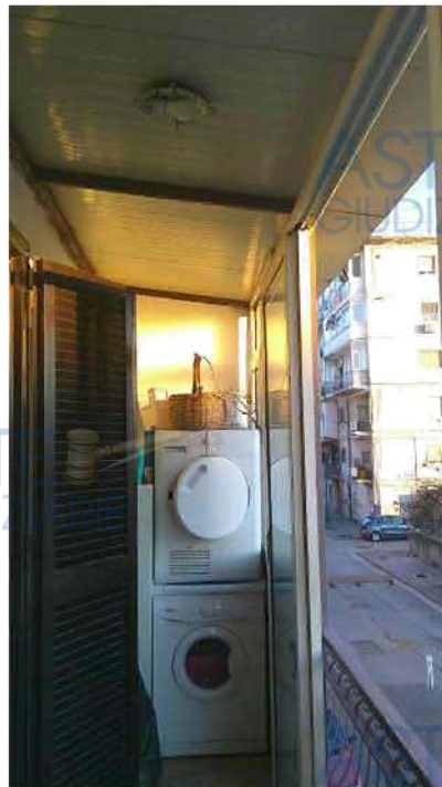
Foto n. 4: • Balcone fronte strada parzialmente chiuso da moduli scorrevoli in alluminio e sormontato da tettoia.
