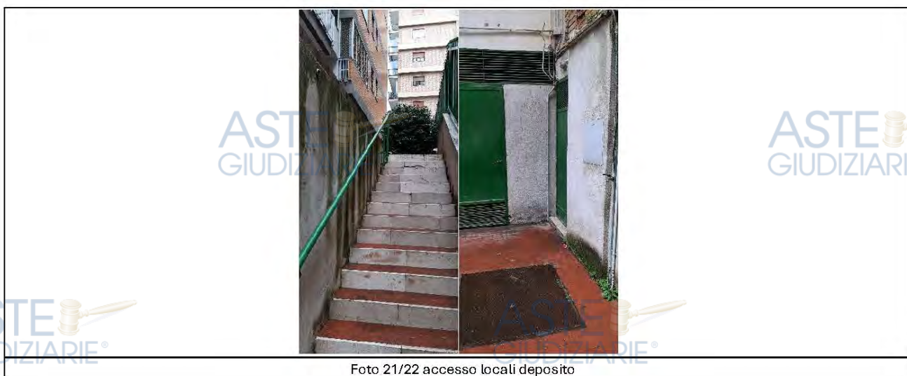
Foto 21/22 accesso locali deposito
