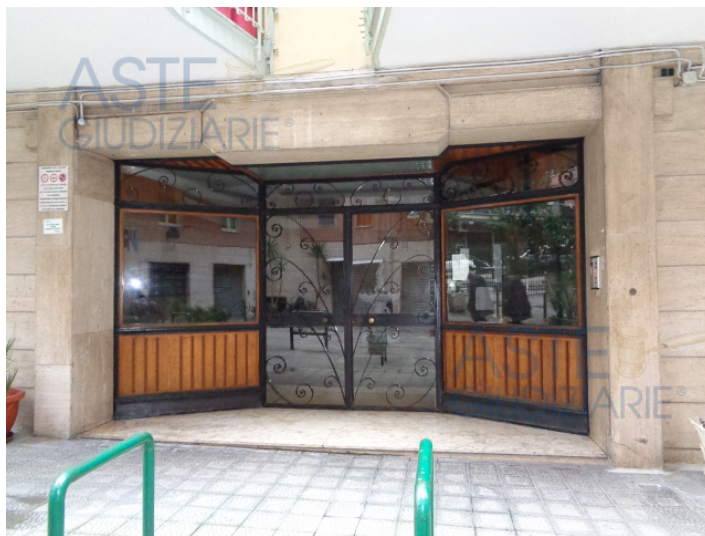
Portone d'ingresso al fabbricato scala A su viale condominiale
