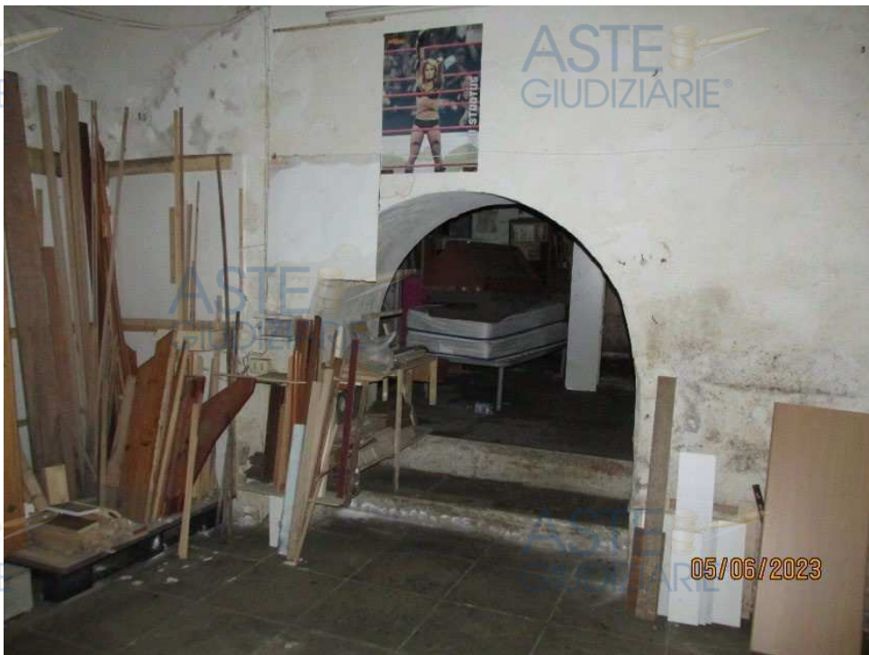
Fotografia 23 – Locale 3: è il secondo dei due ambienti dell'Immobile n. 3 ( catastalmente Sub 8 ) pignorato della presente perizia, vi si accede dal "Locale 2" scendendo due gradini, attraverso un'arcata portante avente un'altezza massima di circa ml. 1,30.
