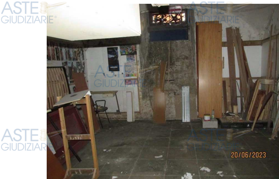
Fotografia 26 – Locale 3 : L'ambiente dispone di una lustriera a “bocca di lupo” prospiciente la strada pubblica di Vico Sant'Eframo Vecchio. Anche in questo caso l'ambiente si presenta in un totale stato di abbandono, occupato da diversi mobili e materiali di ogni genere, le pareti mostrano segni diffusi di efflorescenze di macchia di umidità da risalita, anche il soffitto presenta diffuse macchie di umidità con fenomeni di distacco dello strato superficiale degli intonaci.
