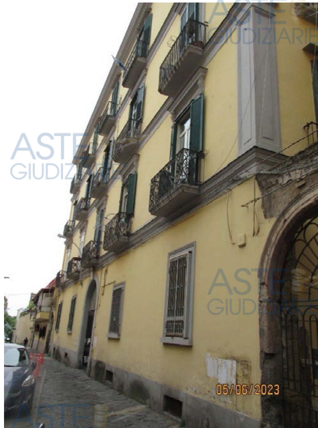
Fotografia 7 – Altra vista del fabbricato da Via Sant'Eframo Vecchio.
