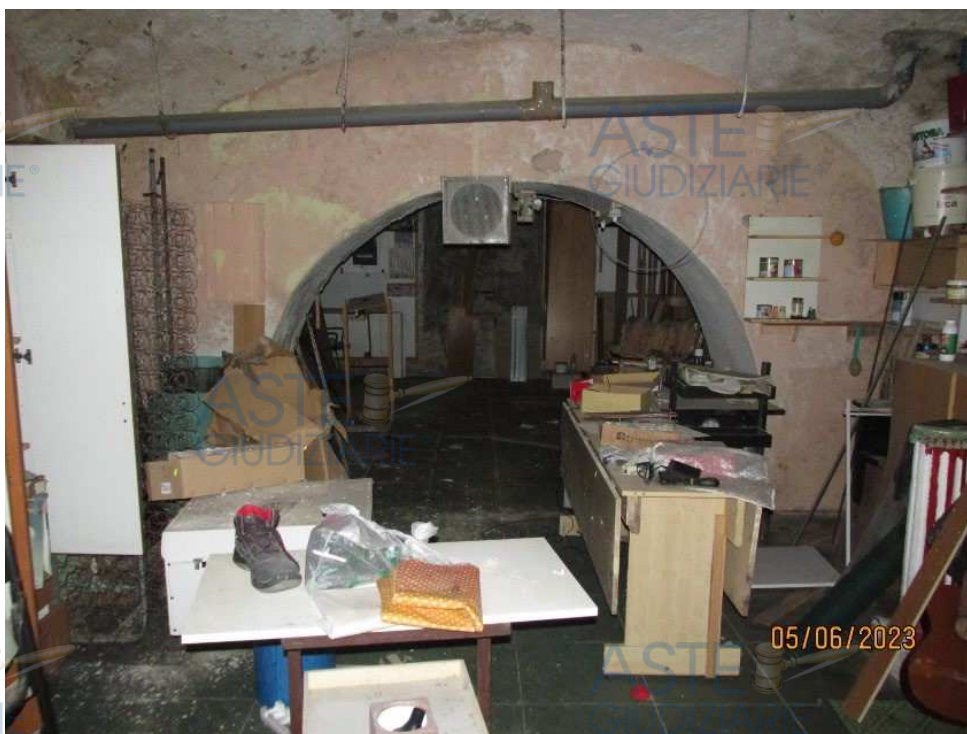
Fotografia 28 – Locale 4 : La pavimentazione è costituita da piastrelle in ceramica; le pareti sono rivestite con intonaci ordinari e tinteggiati con pittura lavabile; il soffitto è costituito da una volta a "vela", rivestito con intonaco grezzo non rifinito e tinteggiato con pittura a tempera.
