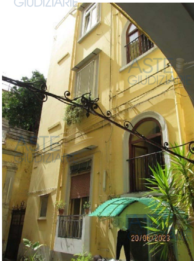
Fotografia 12 – I prospetti del fabbricato che affacciano nel cortile comune presentano le pareti rivestite da intonaci ordinari a finitura liscia e tinteggiate con pittura al quarzo.
