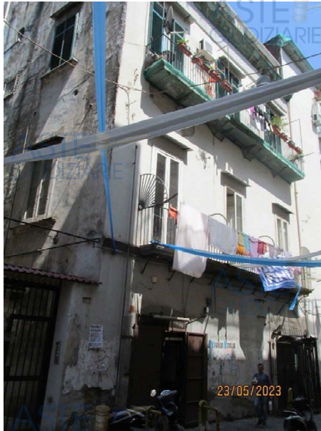
Fotografia 7 – Vista fabbricato da Via Giuseppe Piazzi.
