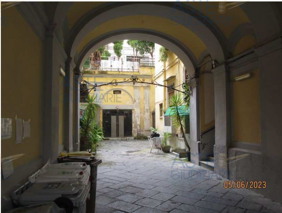
Fotografia 9 – Il varco d'ingresso immette in un androne coperto, pavimentato con basoli pesanti in pietra di “piperno vesuviano”.
