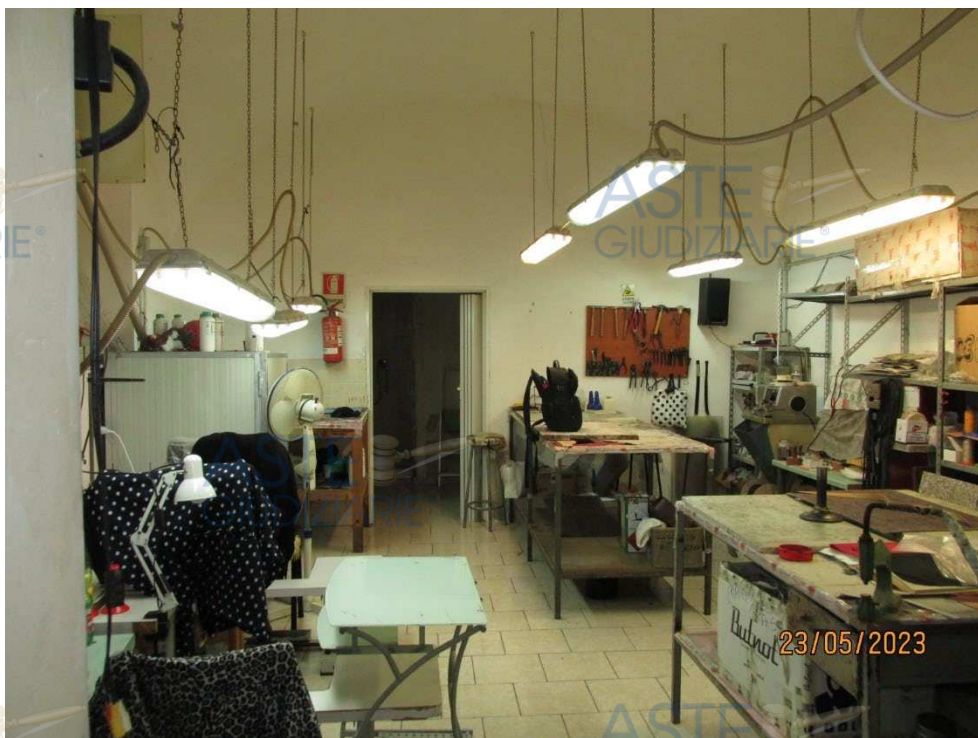
Fotografia 21 – Locale 3: La pavimentazione è costituita da piastrelle in ceramica smaltata; le pareti sono interamente rivestite con intonaci ordinari a finitura liscia e tinteggiate con pittura lavabile; il soffitto è costituito da una volta a “botte” ed è intonacato e tinteggiato con pittura a tempera.
