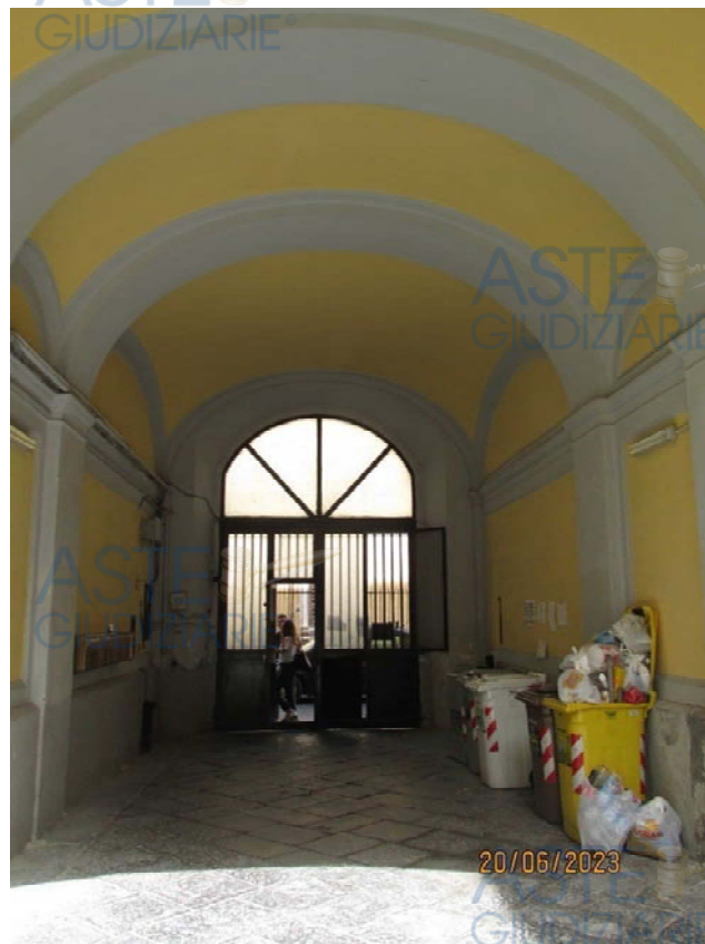
Fotografia 10 –Le pareti dell’androne sono rivestite con intonaci ordinari e tinteggiate con pittura al quarzo, adornate da cornici. Il soffitto è costituito da una volta a “botte” con arcate in sporgenza munite di cornici decorative.
