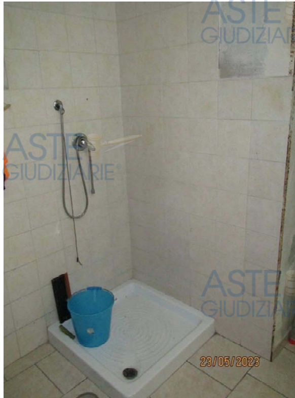
Fotografia 25 – Bagno: le pareti in parte sono rivestite con piastrelle in ceramica smaltata e in parte sono rifinite con intonaci ordinari a finitura liscia e tinteggiate con pittura lavabile.
