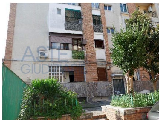
DETTAGLIO FRONTE NORD
