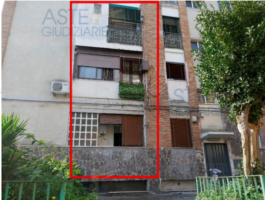
DETTAGLIO FRONTE NORD
