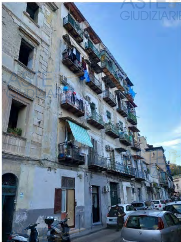
Foto n.1 – Fabbricato via Fontanelle 34
