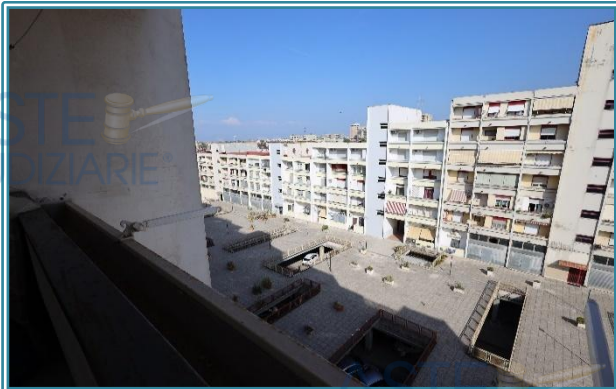
Figura 26 Vista su cortile interno
