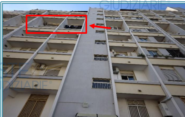
Figura 12 Facciata edificio prospetto est
