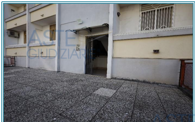
Figura 11 Ingresso da cortile esterno al primo piano
