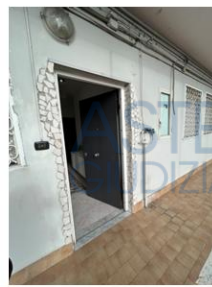
Foto n. 12 - Ballatoio comune d'accesso - accesso all'immobile pignorato
