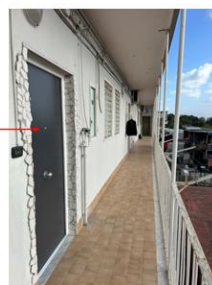
Foto n. 11 - Ballatoio comune d'accesso - accesso all'immobile pignorato
