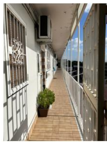
Foto n. 10 - Ballatoio comune d'accesso
