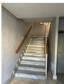
Foto n. 4 - Androne del fabbricato
