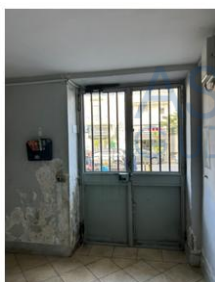
Foto n. 3 - Androne del fabbricato
