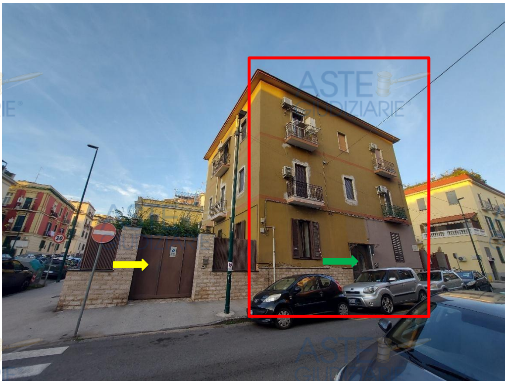
Via di Niso - prospetto principale (sud) fabbricato – indicazione accesso civ.10 (in verde) e accesso passo carraio esclusivo del cespite civ.12 (in giallo)
