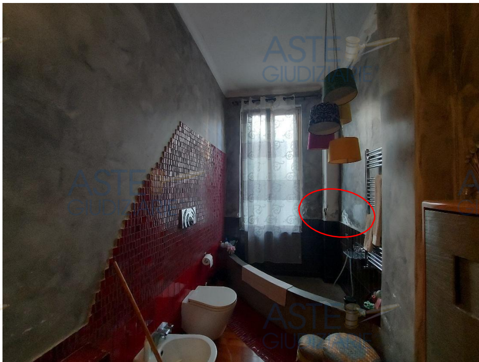
Bagno wc1 - Tracce di umidità di risalita ed in corrispondenza del cavedio della fecale.
