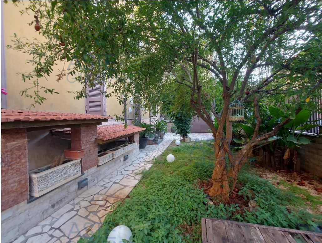
Corte – struttura in muratura a copertura accesso al seminterrato
