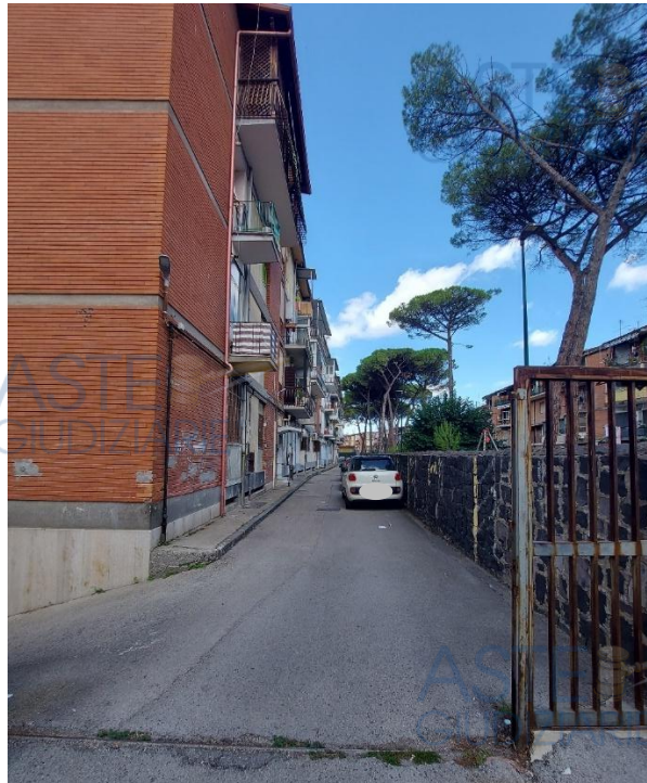
prospetto nord-est fabbricato – indicazione accesso cortile fabbricato cespite
