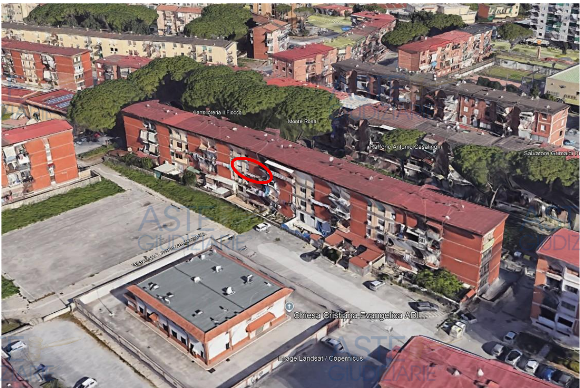
inquadramento territoriale - fabbricato 36 affacci cespite
