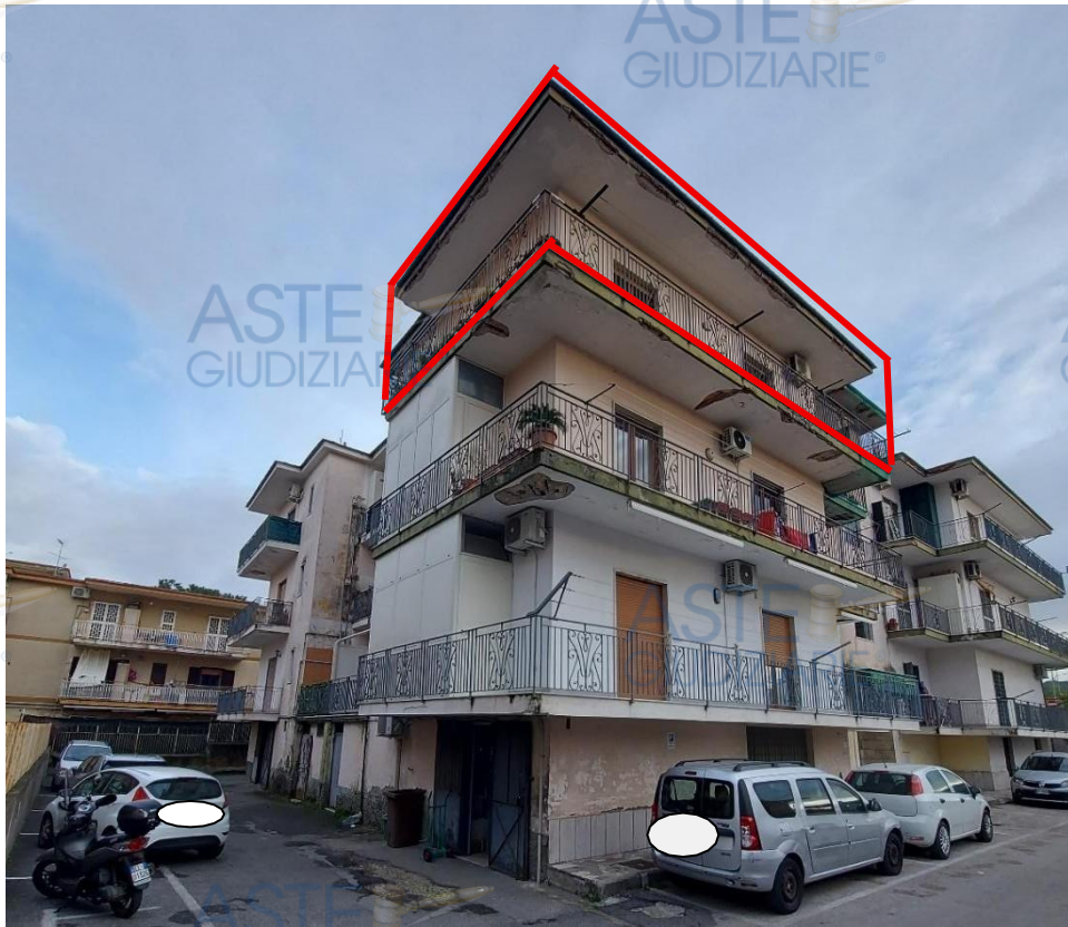
strada privata-fabbricato civ.360 ed indicazione affacci cespite
