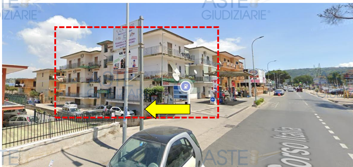
inquadramento territoriale – Corso Italia – individuazione fabbricato civ. 360 e accesso alla strada privata
